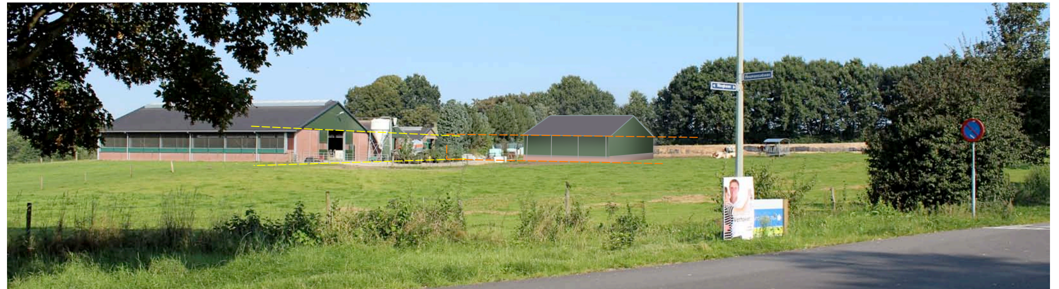
montage van de loods
