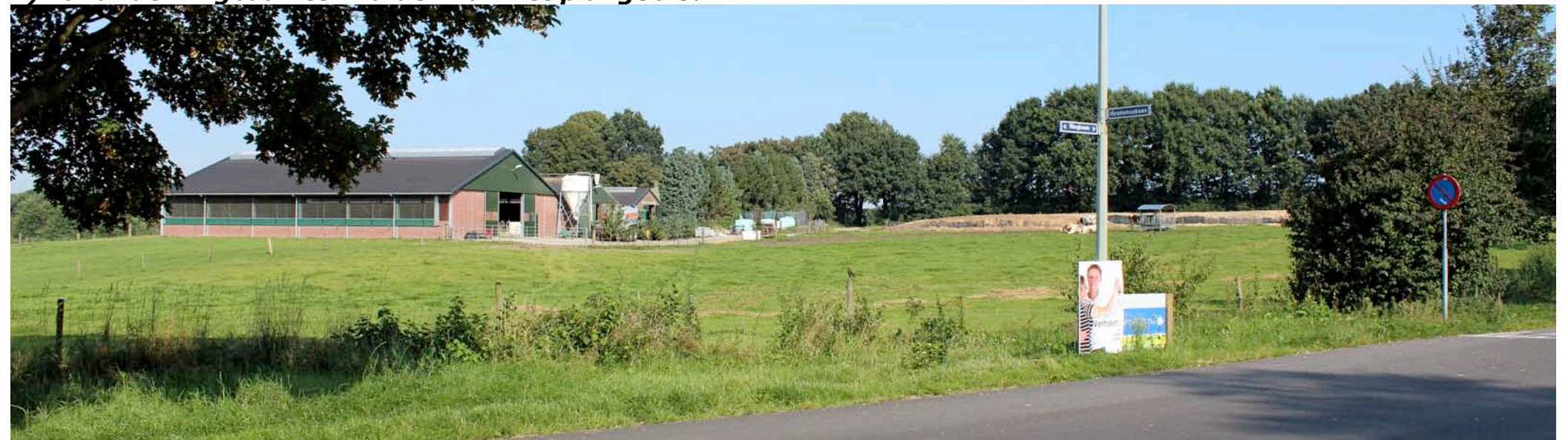
3) vanaf de Ringbaan ten zuidoosten van het plangebied
