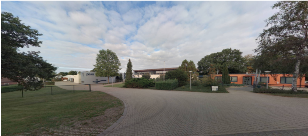
f2.2 Bebouwing aan en toegang van de Lindenlaan 41
