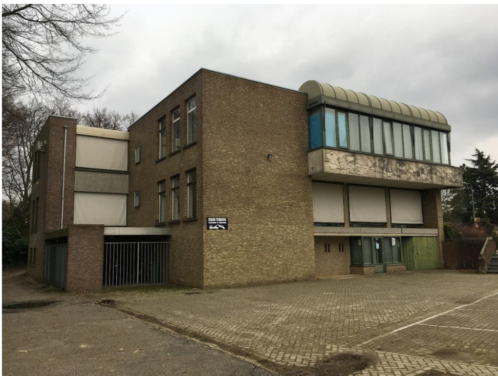
Figuur 2 De zuidwestkant van het kantoorgebouw. Op de tweede verdieping is een uitbouw gerealiseerd.
