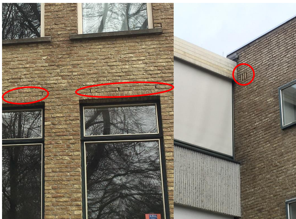
Figuur 2 In de gevel van het kantoorgebouw zijn meerdere openingen in de vorm van o.a. stootvoegen en ventilatieopeningen. Hierdoor kunnen vleermuizen toegang krijgen tot de spouw.
