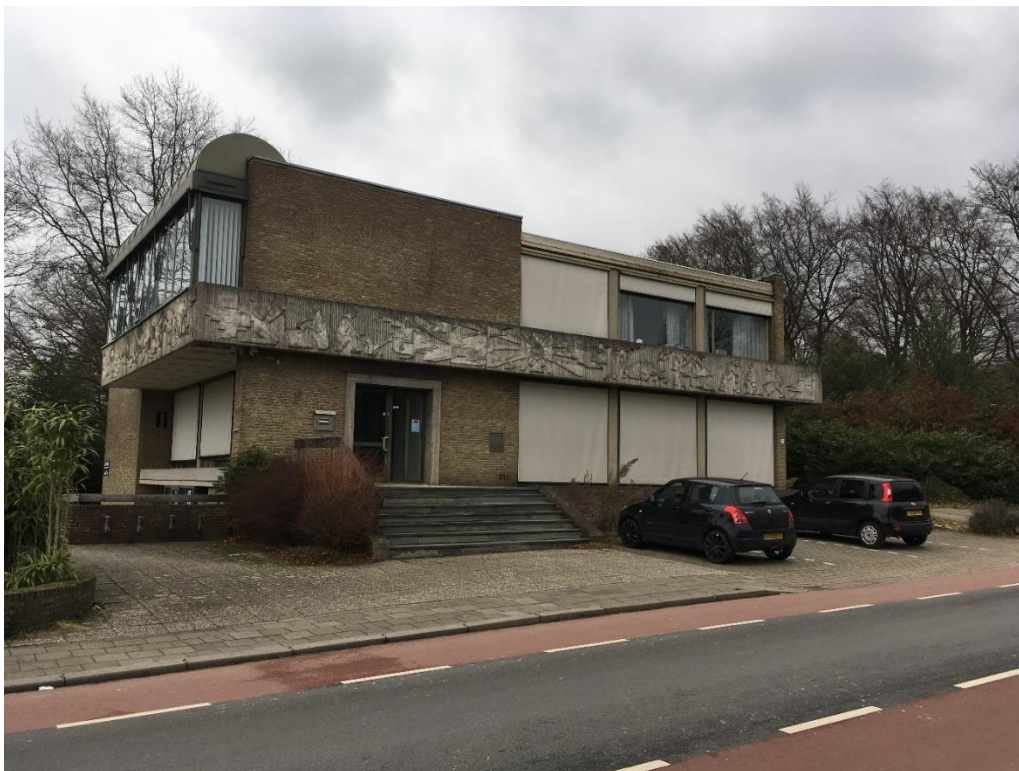
Figuur 1 De planlocatie is gelegen aan de Groesbeekseweg 19 te Mook en bestaat uit een gemetselde muur met spouw en plat dak.
