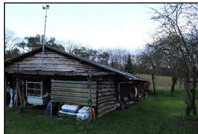
Figuur 4. Noordaanzicht paardenstal/opslagschuur.
