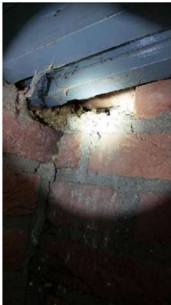
Figuur 4.4.4. Opening in de muur waardoor vleermuizen de spouw kunnen bereiken.
