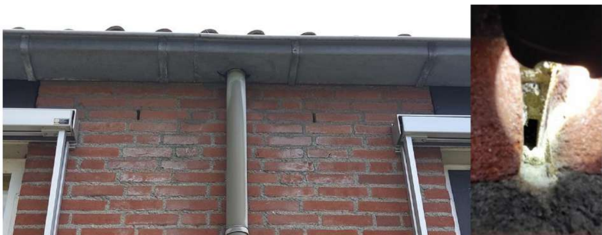
Figuur 4.4.3. De basisschool bevat op verschillende plekken in de buitengevels open stootvoegen.
