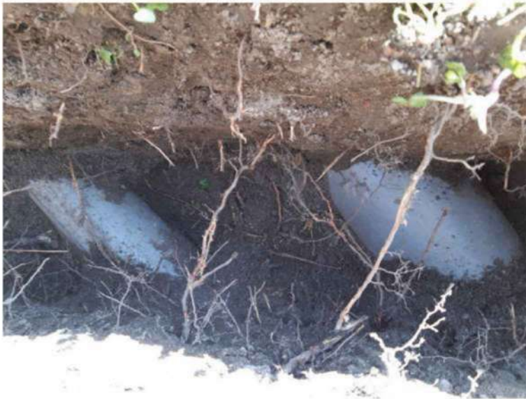
Afbeelding 7, de PVC buizen in de ondergrond van proefsleuf B.
