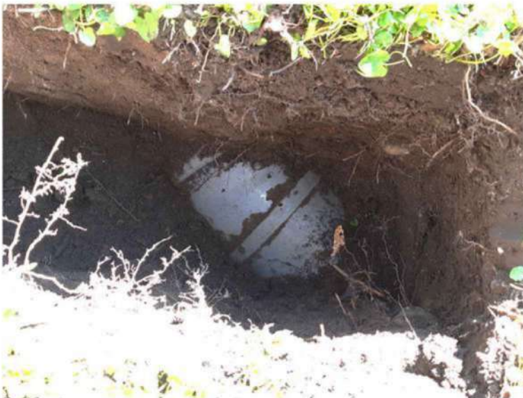
Afbeelding 8, de buis met diameter 200 mm knikt in profielsleuf C om vervolgens parallel aan de bomen verder te lopen.
