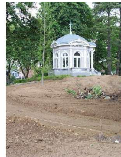
Figuur 35: Uitvoering renovatie in 2003
