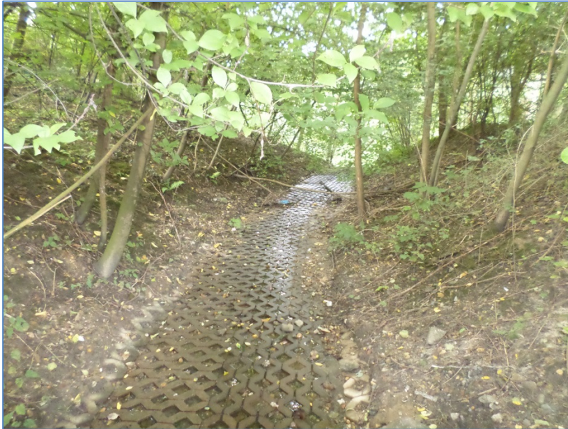
Foto 5 Uitloop riooloverstort ter hoogte van de Hussenbergstraat
