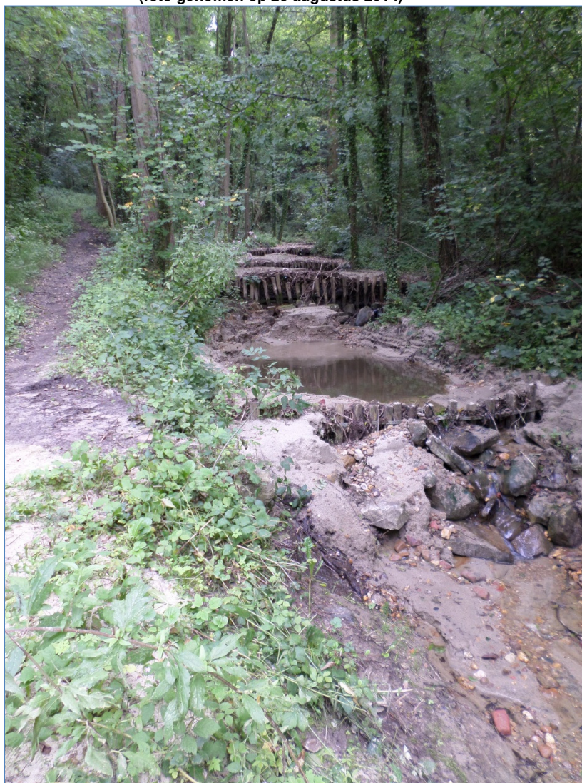
Foto 1 Zandvang onder aan de helling in de Hussenbeek ter hoogte van Broekhoven 10 (foto genomen op 25 augustus 2014)
