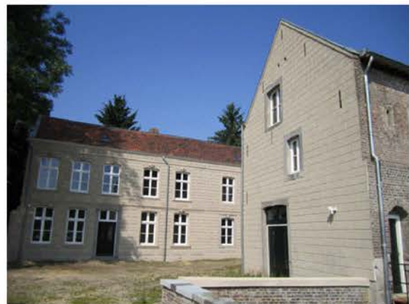
fig. 4 Zicht op bestaande binnenplaats
