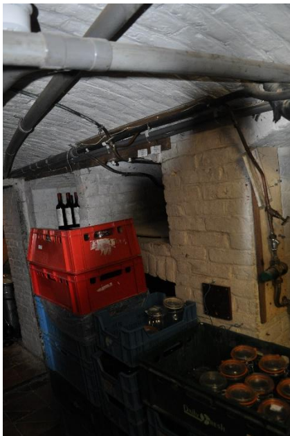
45-46-47 Gemetselde getoogde kelder met zij nissen met onderverdeling voor opslag
