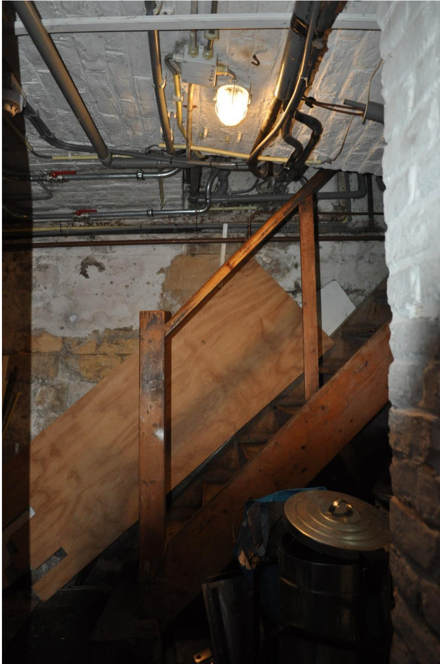
50 Eenvoudige houten keldertrap.
