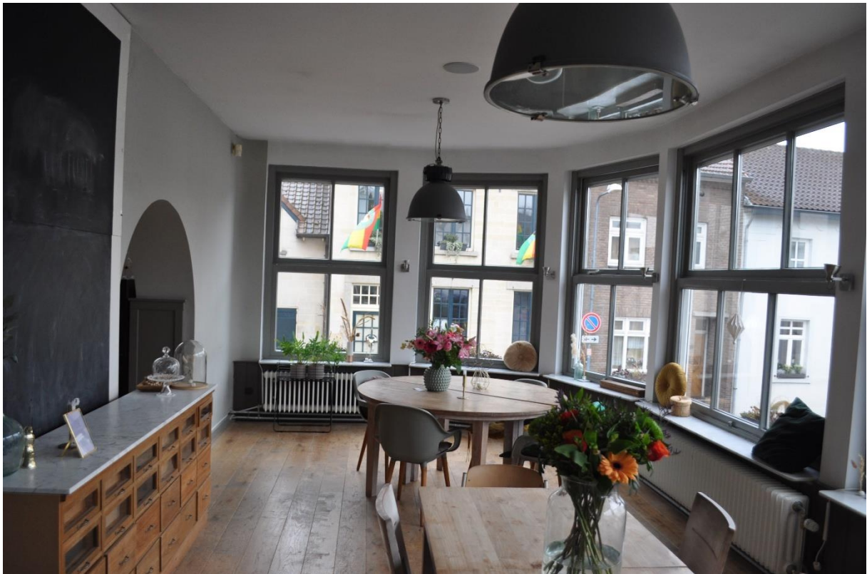
10. Aangebouwde serre uit 1956 met schuiframen in hout die niet door kunststof zijn vervangen.
