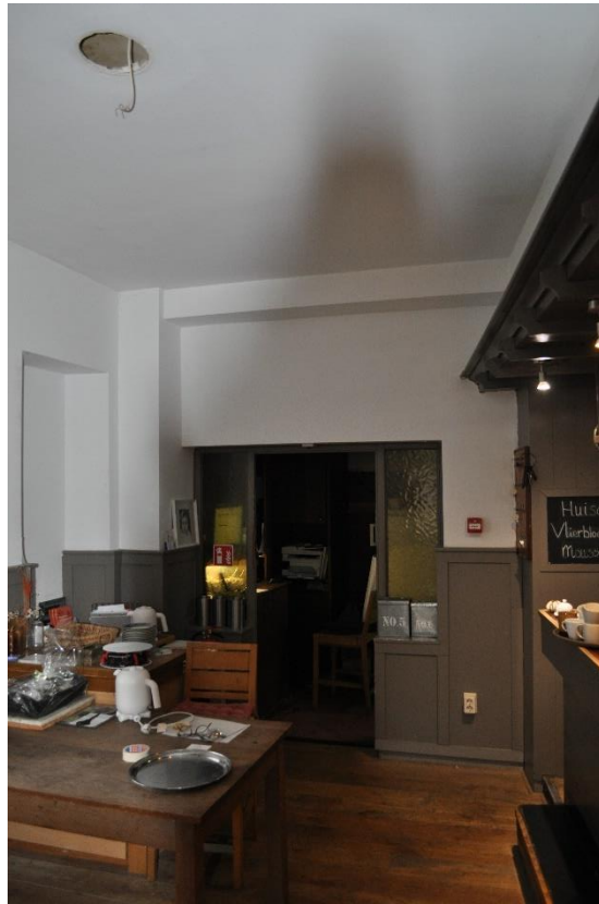
9. Doorgang naar berging en toegang kelder.
