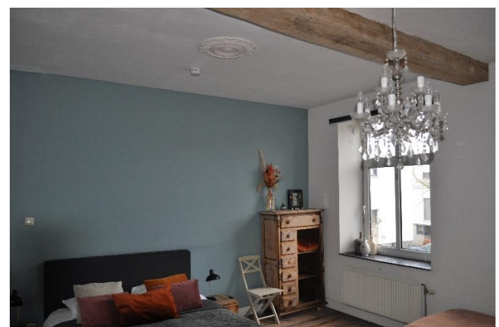
29. Houten balk in gipsplaat als restant oude structuur
