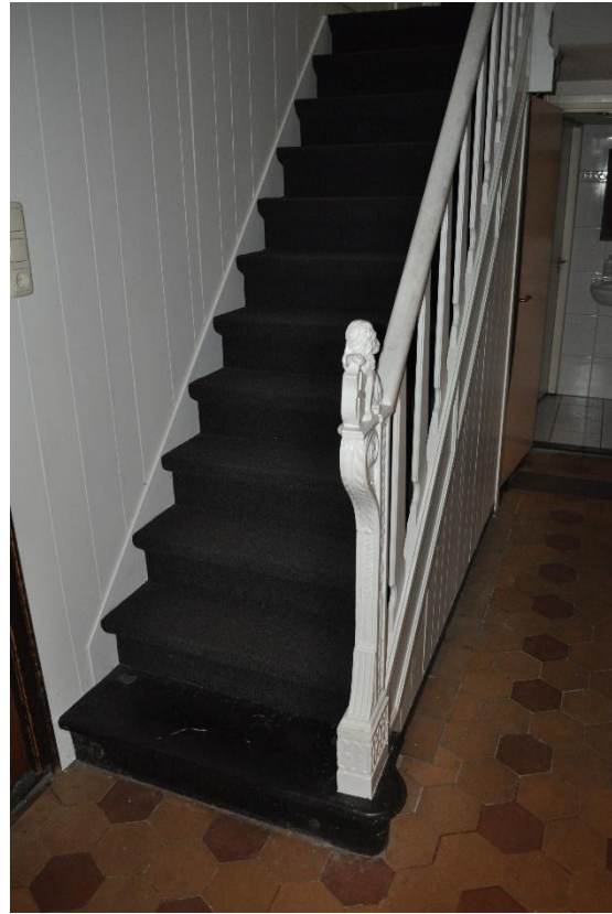
5. Trap met hardsteen bloktrede. De trappaal dateert van rond 1900
