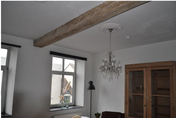
30. Houten balk vloer in plafond
