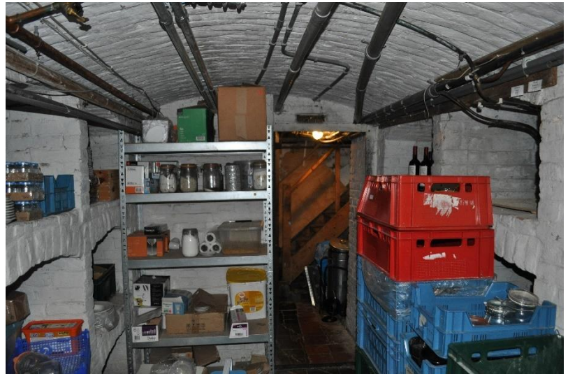
45-46-47 Gemetselde getoogde kelder met zij nissen met onderverdeling voor opslag
