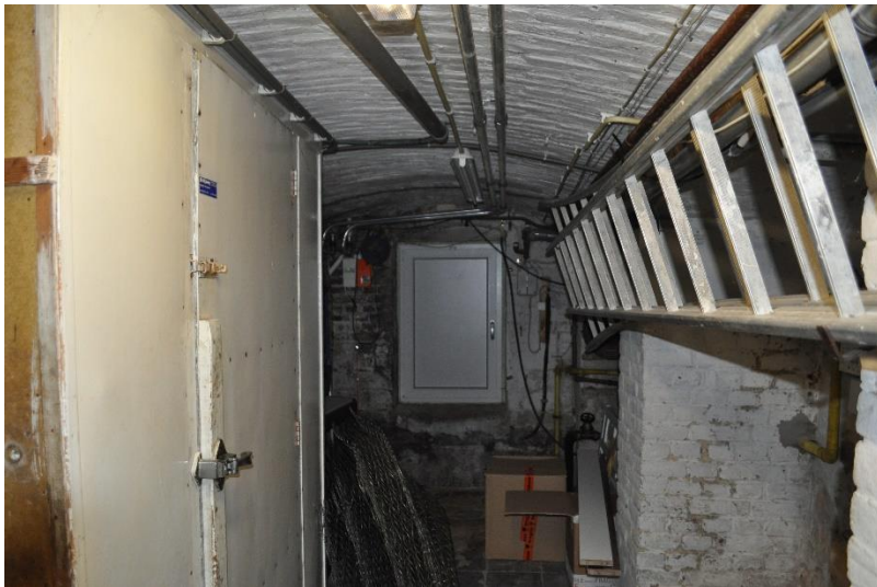
44. Luik straatzijde in kelder
