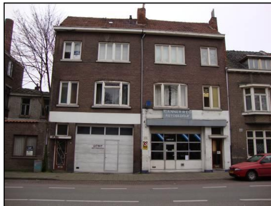
Te slopen panden aan de Cannerweg 8-10
