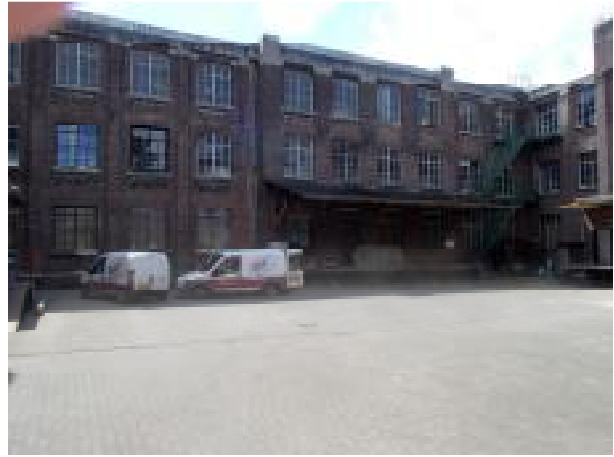
Foto 2: Binnenplaats Carré met klinker-verharding.
