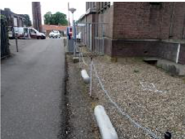
Foto 3: Foto vanaf uitgang richting schoorsteen. Links asfalt (nabij kern 25). Rechts markering proefgat 22 onder tegels.
