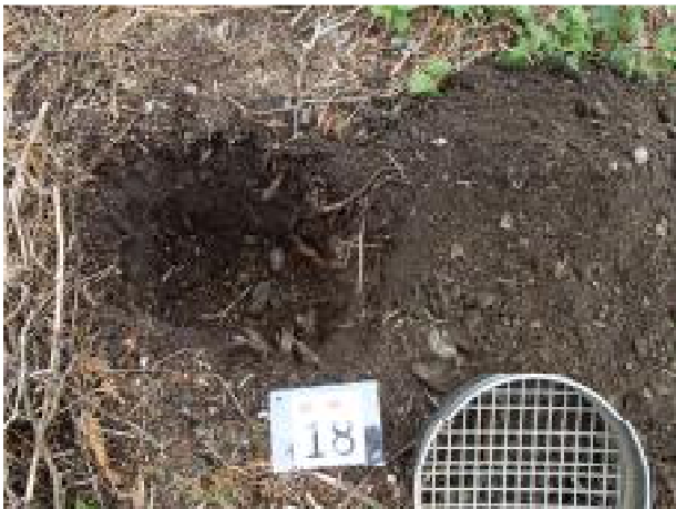
Foto 9: In proefgat 18 is geen asbest aangetroffen. De grond wordt gezeefd op een zeef van 16 mm.
