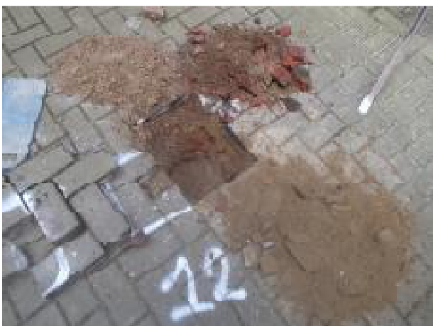
Foto 11: Onder de beklinterde binnenplaats is een laag baksteen aanwezig.
