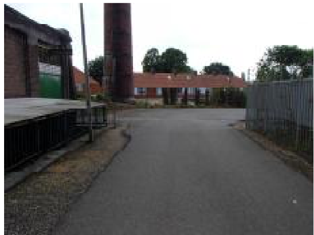
Foto 4: Links ketelhuis. Het hele terrein is opgehoogd ten opzichte van de omgeving. Zie lager gelegen woningen aan de Cannerweg.
