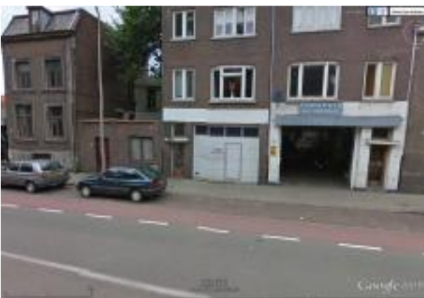
Foto 5: Voormalige garage Creemers-Weijenberg Cannerweg 8 en 10. Wordt gesloopt ten behoeve van nieuwe uitgang Carre Winkelcentrum.
