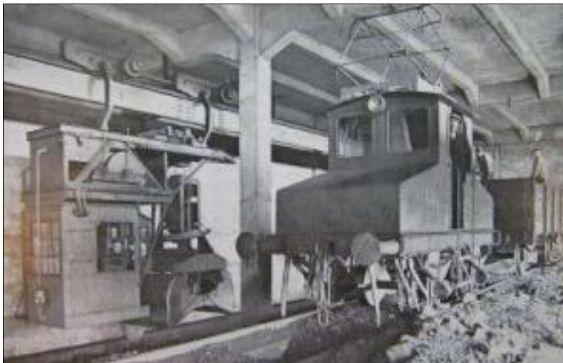
afb. 3.48 – O – aanvoer kolen met elektrische locomotief Bron: de uitbreiding van de gasfabriek te Maastricht
