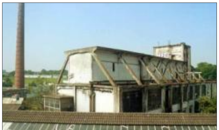
afb. 3.20 – huidig oostelijk aanzicht 'kathedraal'
