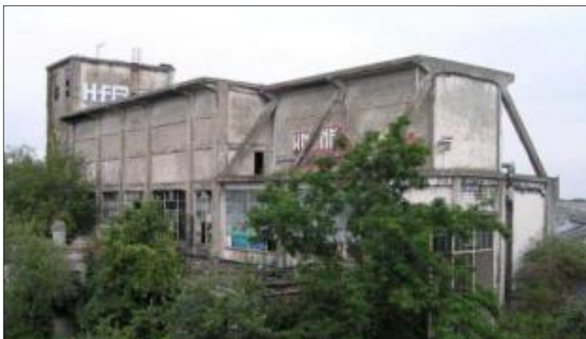
afb. 3.28 – aanzicht complex vanuit zuidelijke richting
