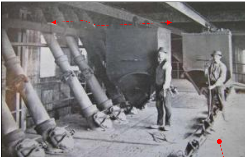
afb. 3.52 – S – het laden van de ovenkamers Bron: de uitbreiding van de gasfabriek te Maastricht
