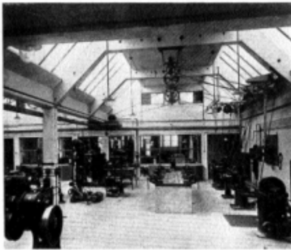
6 Praktijklokaal met betonspanten uit de Nijverheidsschool te Groningen - Wiebenga en Van der Vlugt, 1922
