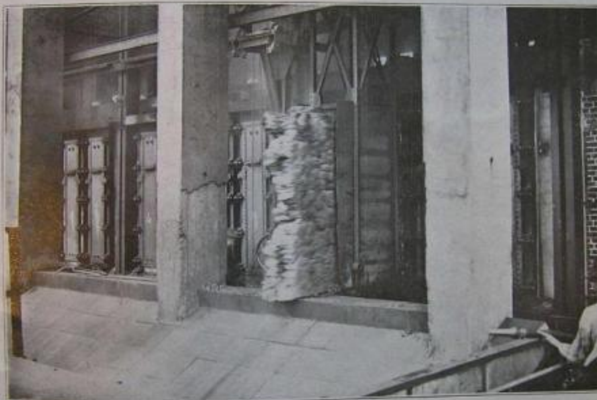
Afb. 5. Het uitstooten van de cokes op de bluschelling.
