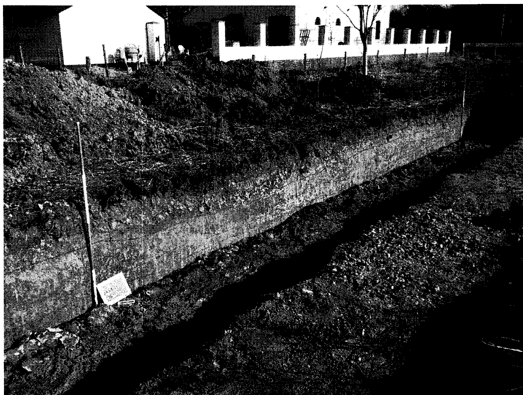
Afb. 10. Het wegtracé in het profiel, gezien vanuit het westen. Ook de locatie van twee OSL buizen is op deze foto zichtbaar.
