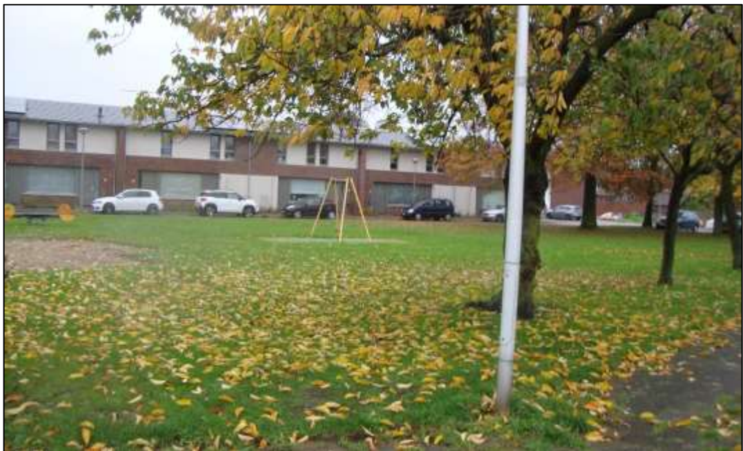
Zicht op het parkje tussen Kasteel Oostlaan, Kasteel Oostplein en Kasteel Walburglaan met zicht op de nieuw gerealiseerde woningen aan de noordwestzijde van het Kasteel Oostplein. Na de bouw van de drie woonclusters maakt het parkje deel uit van de groene wig in zuidoostelijke richting vanaf de Meerssenerweg tot aan de Kasteel Rivierenstraat.
