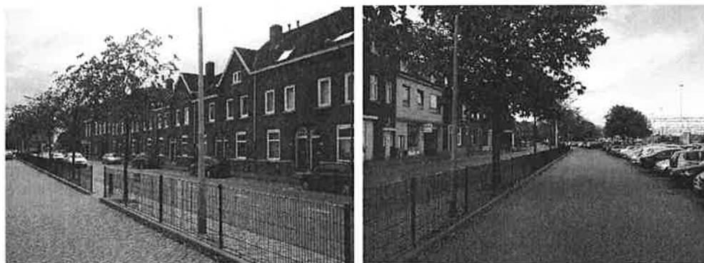
Afbeeldingen: uitzicht woningen Parallelweg op huidig P+R terrein
