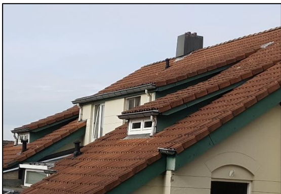
Figuur 3.1 Complex 2-0305 ligging van dakpannen
