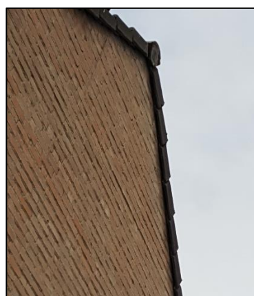
Figuur 3.4 Spleten tussen muur en dakpan
