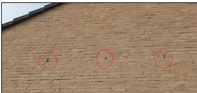
Figuur 3.2 Complex 2-0350 open stootvoegen
