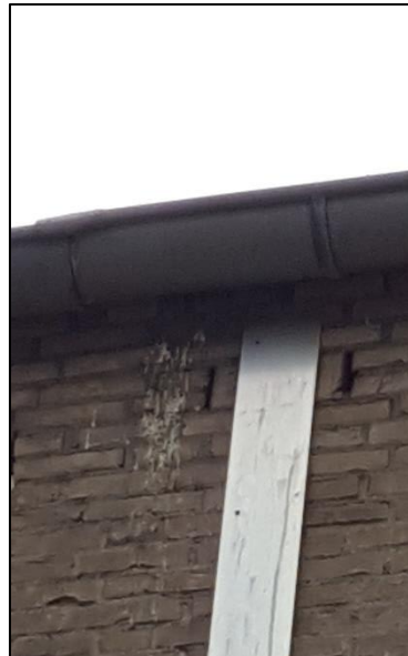
Figuur 3.6 Complex 1-0120-BR Open stootvoegen
