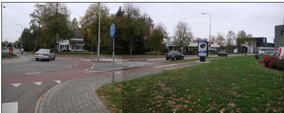
De Bergerstraat, ten zuiden van de projectlocatie
