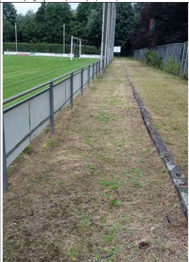
Fotonummer: 10 Omschrijving: Halfverharding rondom veld 1
