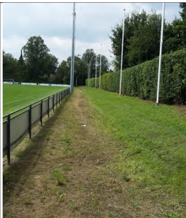
Fotonummer: 12 Omschrijving: Halfverharding en talud
