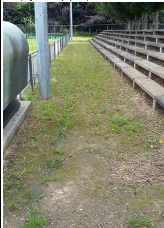
Fotonummer: 9 Omschrijving: Halfverharding rondom veld 1
