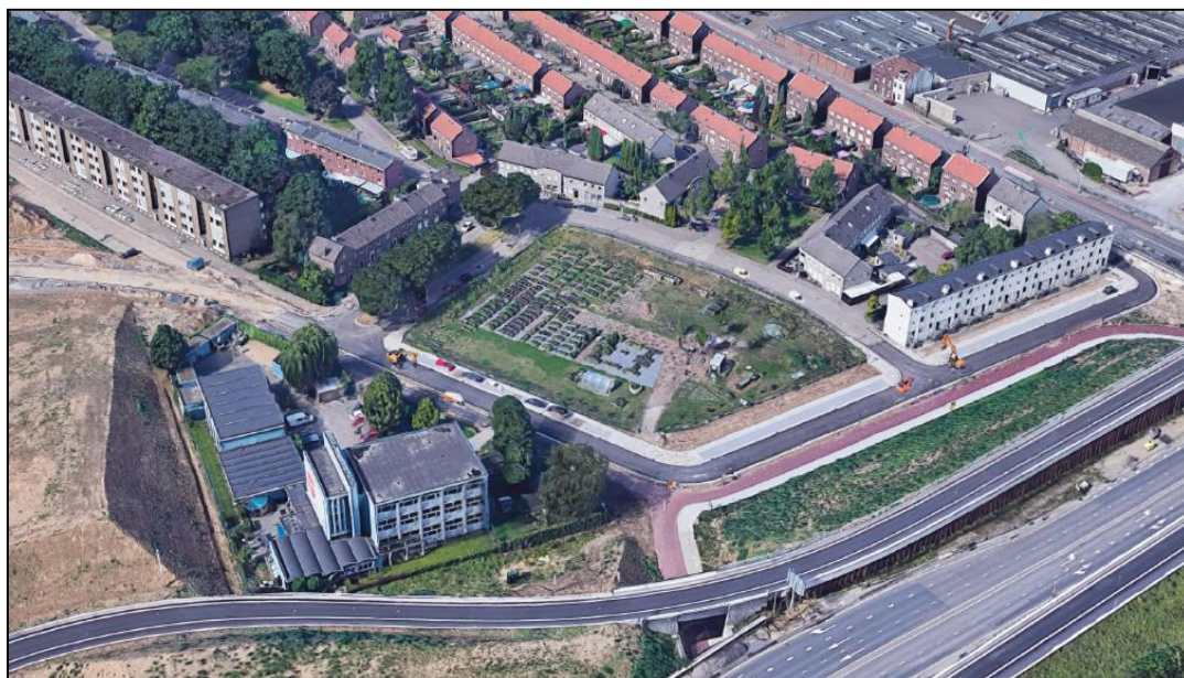
Perspectieffoto recente situatie voor amovering tijdelijk volkstuintencomplex
