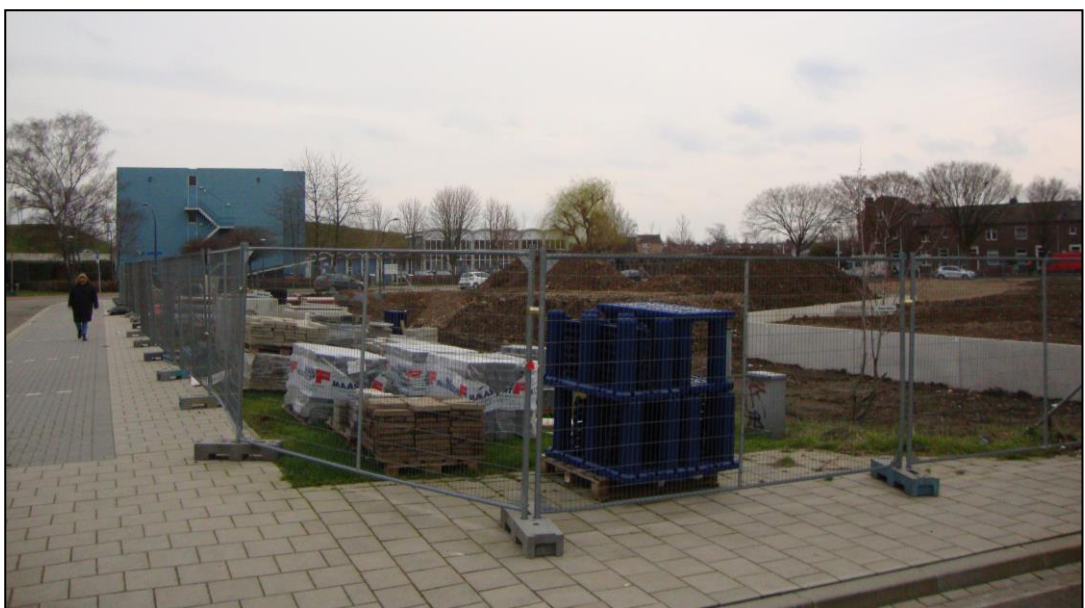
Plangebied vanuit noordwestelijke hoek
