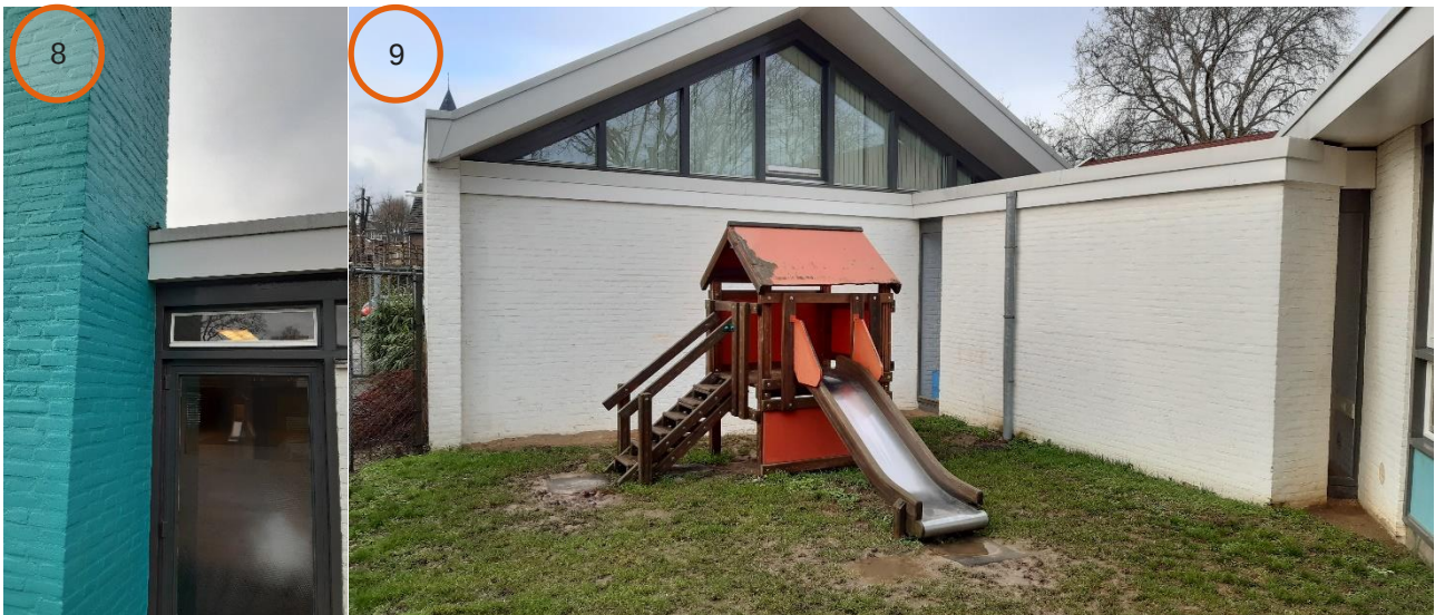
Links: openingen in aansluitingen van gevel naar gemetselde muren bieden toegang voor vleermuizen. Rechts: Afwerking langs dakranden bieden mogelijk verblijfplaatsen voor vleermuizen.
