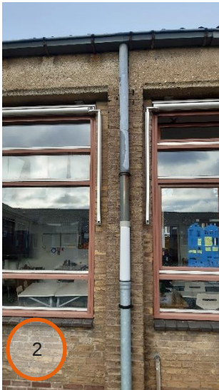
Links: diverse opening in scheuren en stootvoegen in gevels voor vleermuizen. Rechts: Overstekende kantpannen bieden toegang voor vleermuizen en vogels.
