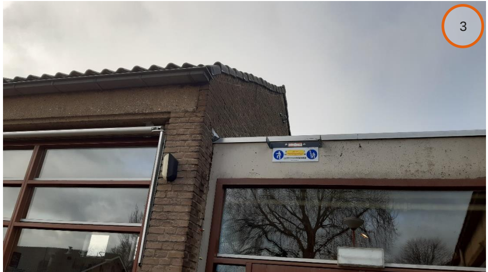
Links: diverse opening in scheuren en stootvoegen in gevels voor vleermuizen. Rechts: Overstekende kantpannen bieden toegang voor vleermuizen en vogels.
