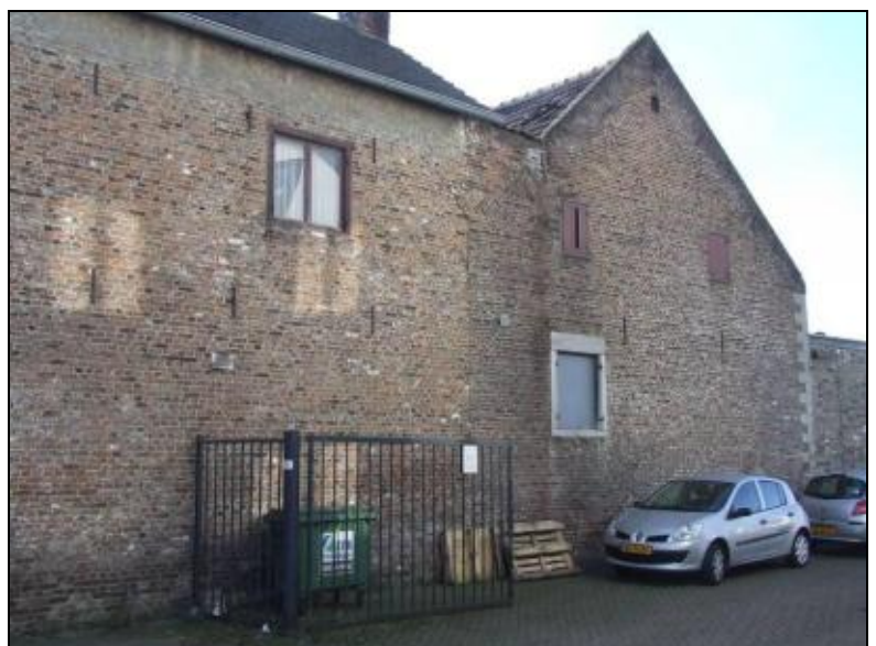
Figuur 10c: De noordelijke zijgevel van het woonhuis (links) en het huidige garagepand (rechts).
