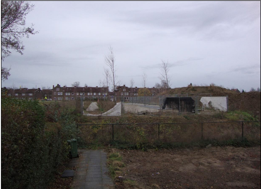
Het reeds aangelegde gedeelte van de aansluiting op de Groene Loper. Het hoogteverschil met de Generaal Eisenhowerstraat (circa 1,5 meter) is hier duidelijk zichtbaar.
