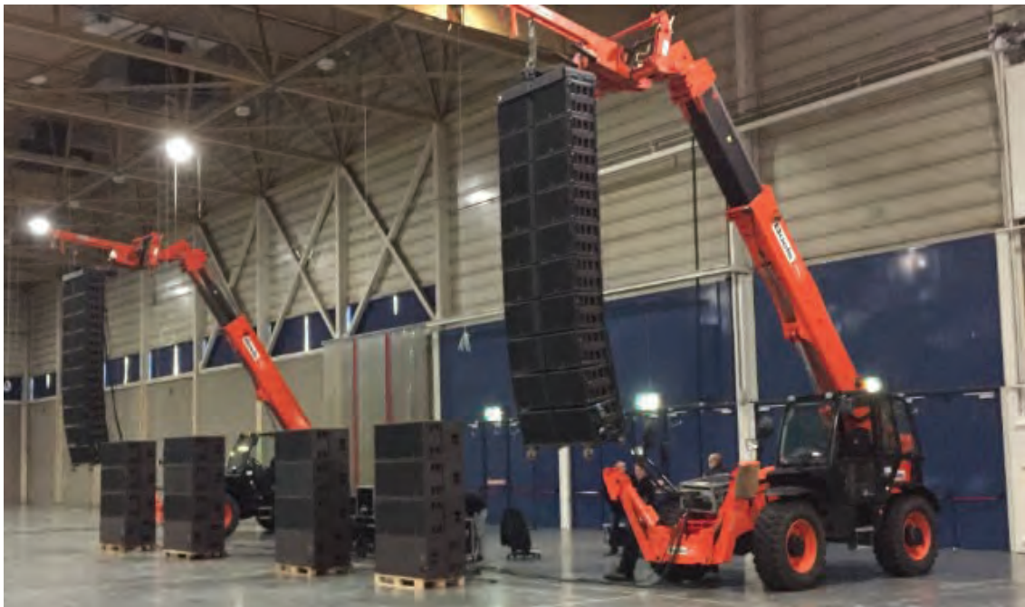
Figuur 3: Geluidinstallatie tijdens de geluidmetingen
