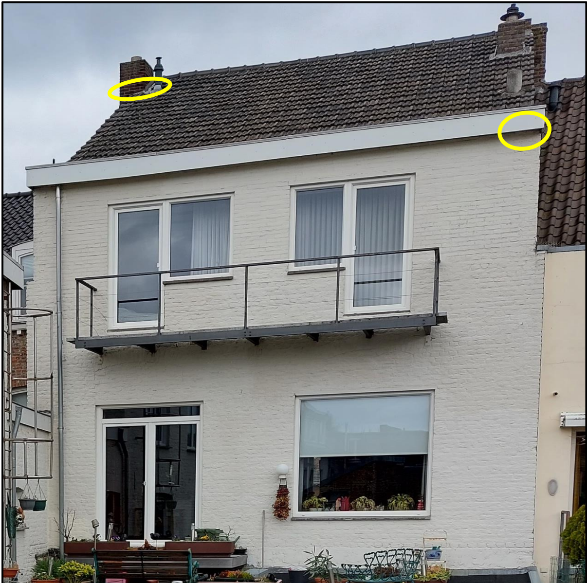
Figuur 4.1 weergave potentiële verblijfplaatsen van vleermuizen onder het daklood en achter de daklijst binnen de gele markering.
