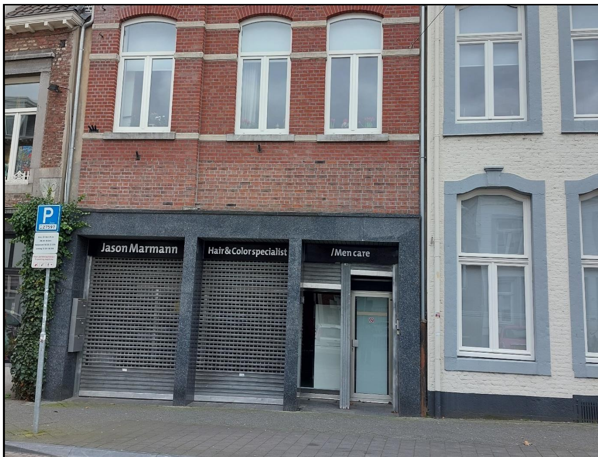
Figuur 2.3 Weergave van de pui dat toegang biedt tot de kapperszaak en de ramen eerste verdieping. De pui en de kozijnen zullen worden vervangen.
