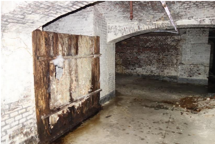
Foto 17: beeld van een gedeelte van de kelder onder het Spoorgebouw
