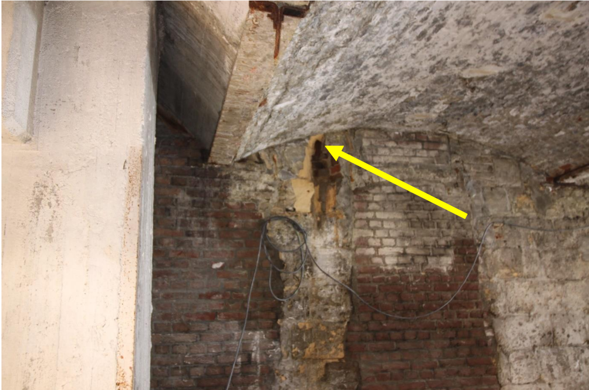
Foto 13: In de gewelfde kelder (westelijke deel van de kelderruimte van de Eiffel, richting de Belgen) is eveneens een franjestaart aangetroffen hoog weggekropen in dit gat, op de rand van de muur en het plafond
