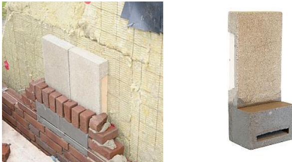
Foto 16: impressie van het toepassen van de inmetselfkast voor de gewone dwergvleermuis
