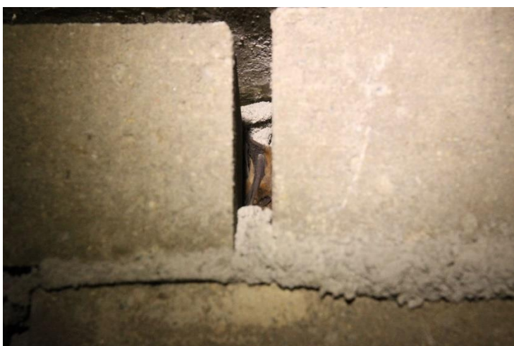
Foto 12: Tussen de betonblokken in de afgesloten gang richting de Timmerfabriek (oostelijk deel van de Eiffel kelder) zaten in totaal 2 gewone dwergvleermuizen op 25 januari.
