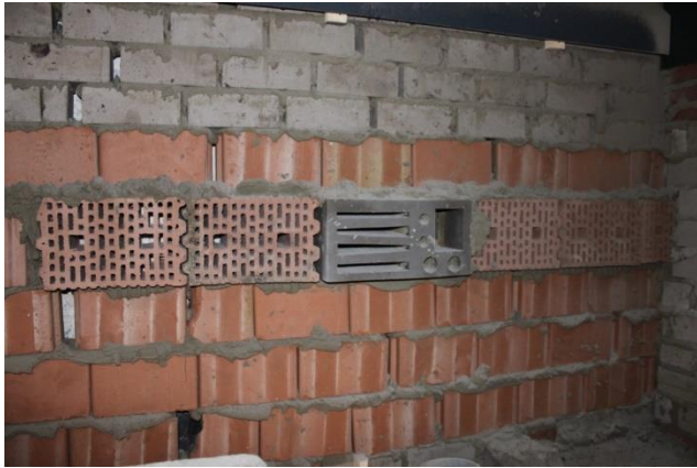
Foto 18: betonnen vleermuissteen ingemetseld tussen porotherm blokken in een vleermuiskelder in Oisterwijk
