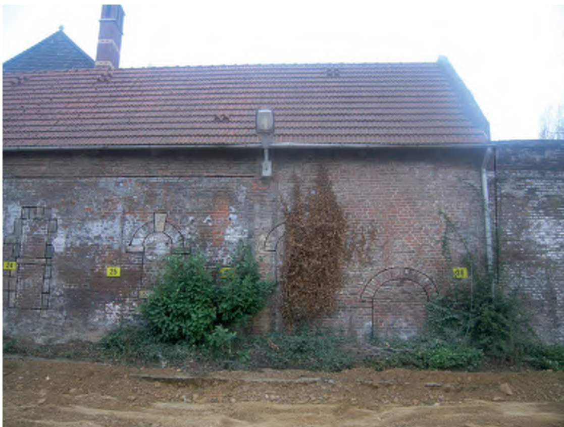
Afb. 15 a. Gebouw ten noorden van werkput 1, dit is tussen 1782 en 1812 mogelijk gebruikt als metaarhuisje van de Joodse begraafplaats. b. Detail van het mogelijke metaarhuisje, met daarop aangegeven de aanwezige bouwsporen.
