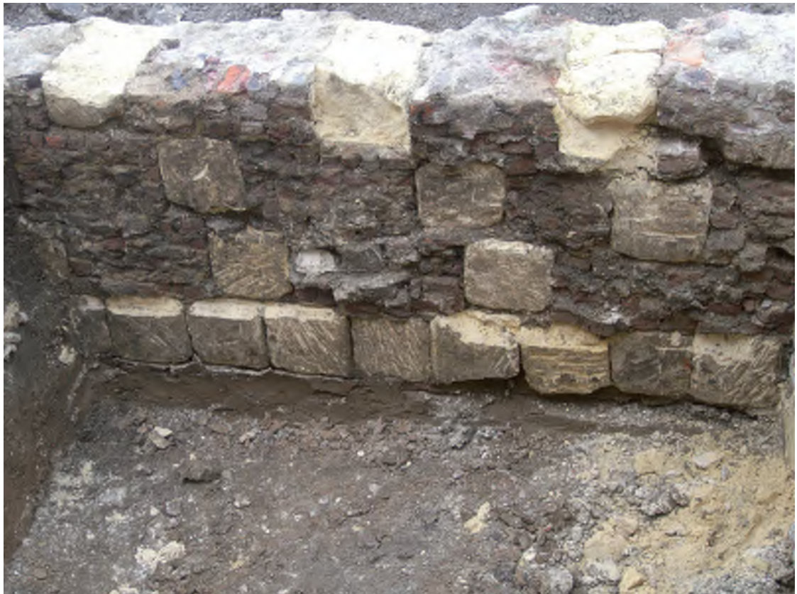
Afb. 14 Aanzicht van muur S75, vanuit het noorden gezien.
