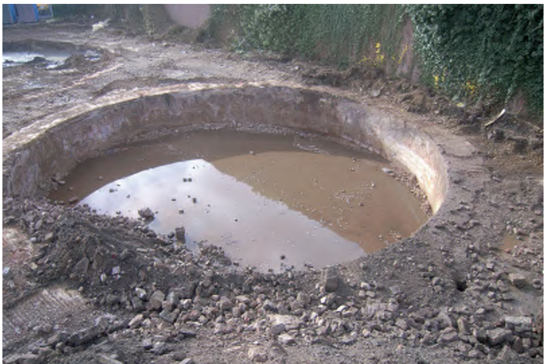
Afb. 31 Opname van de meest westelijke gashouder, nu deels ontgraven.
