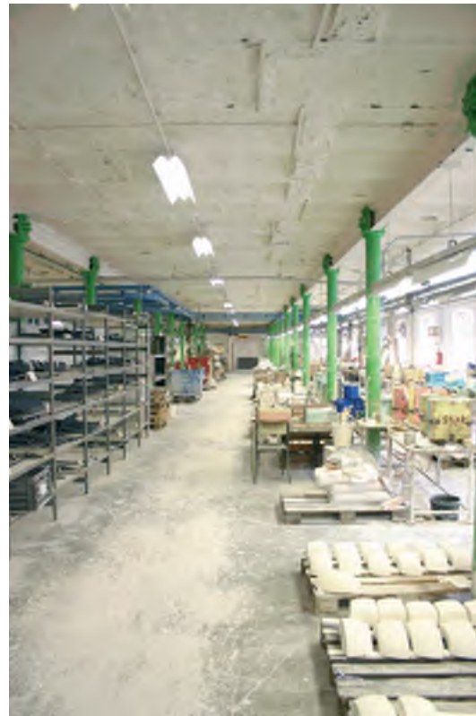
Afb. 93 Een overzicht van de begane grond van het gebouw 21 met ijzeren kolommen, ijzeren liggers en gemetselde troggewelfjes op staal.
