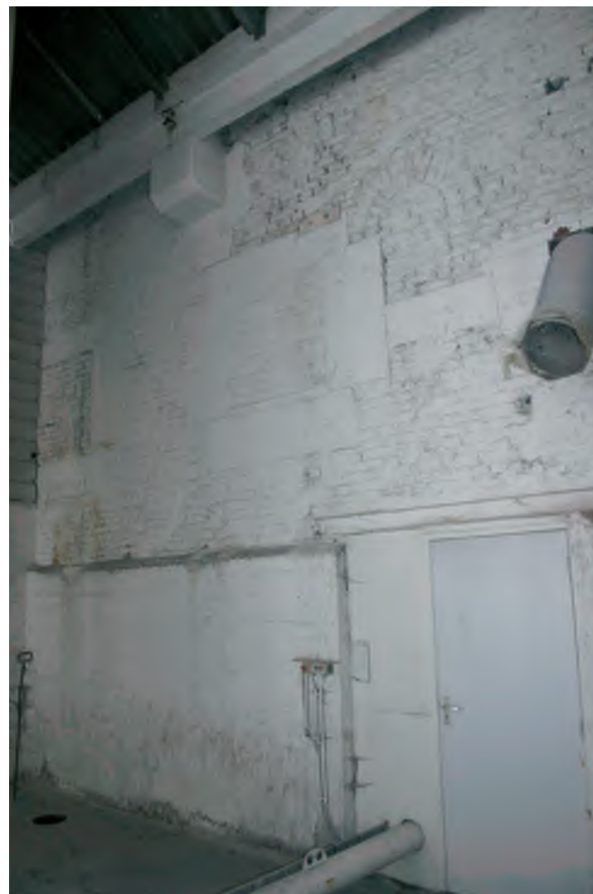
Afb. 88 Bouwsporen zichtbaar vanuit het gebouw 19 in de muur van het gebouw 20/21.
