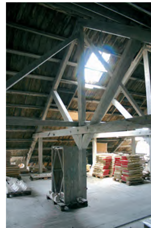
Afb. 95 Een deel van de kapconstructie van het gebouw 21.
