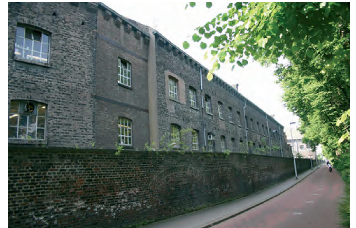
Afb. 89 De straatgevel van het gebouw 21 met daarvoor een deel van de ommuring van het terrein. Links op de foto het wigvormige bouwdeel dat de gebouwen 21 en 22 met elkaar verbindt.
