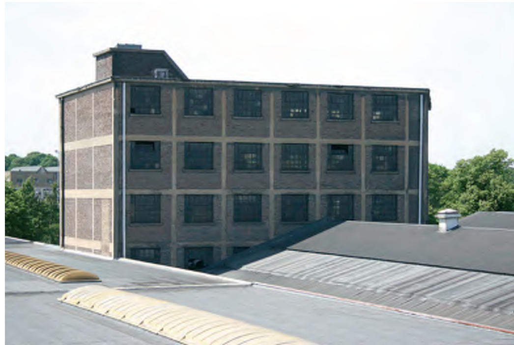
Afb. 45 Het gebouw 2 gezien vanaf gebouw 7. Op de voorgrond delen van de platte daken van de gebouwen 44 en 45, rechts op de foto de een fragment van de daken van gebouwen 1a en 1c.
