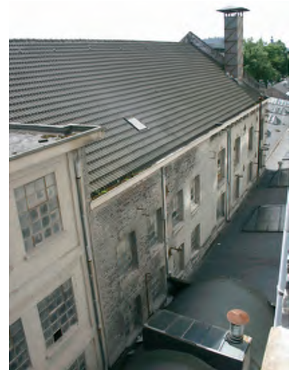
Afb. 119 De 'achtergevels' van de gebouwen 34 en 33 (van links naar rechts) gezien vanuit gebouw 31.
