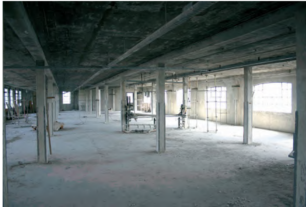
Afb. 121 De betonconstructie van het gebouw 35 op de bovenste verdieping.
