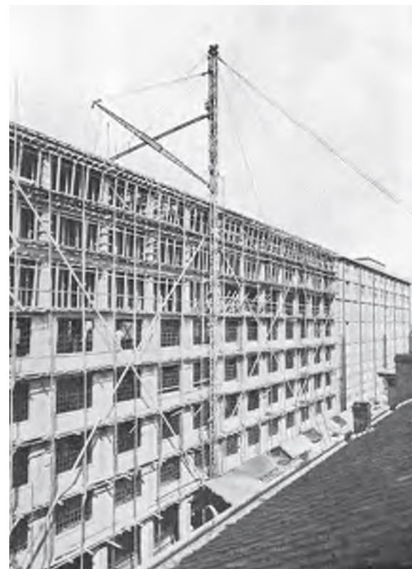
Afb. 61 De Eiffel II in aanbouw (circa 1930). De begane grondvloer heeft een vloerplaat, balken en kolommen. De zeven verdiepingvloeren en het dak zijn balkloze platen (paddestoel-systeem). De gevels zijn van grijze cementsteen tussen vakwerk van beton.
