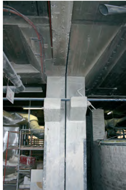
Afb. 73 De aansluiting van de betonconstructie van het oudste deel van het Eiffelgebouw (links) en de betonconstructie van de eerste uitbreiding uit 1930 (rechts).
