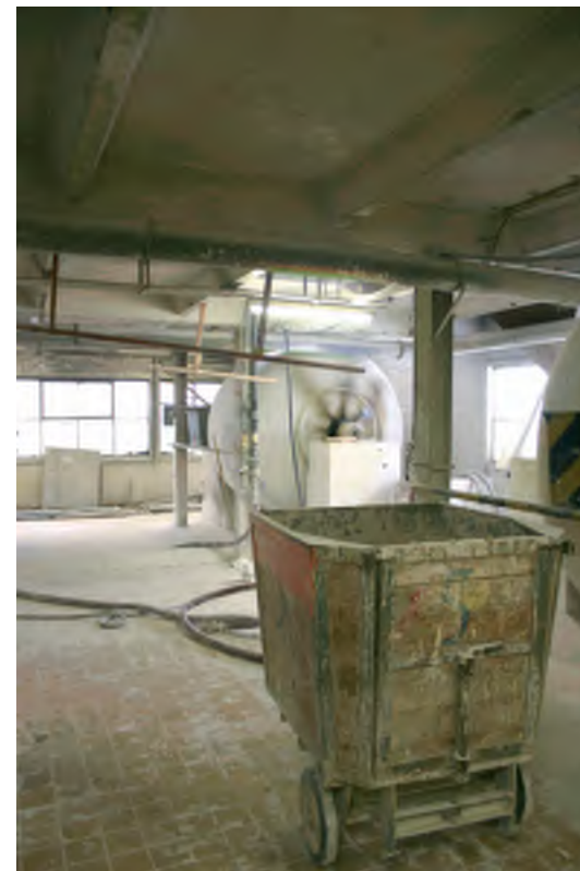
Afb. 102 De staalconstructie met de betonvloeren van het gebouw 26.
