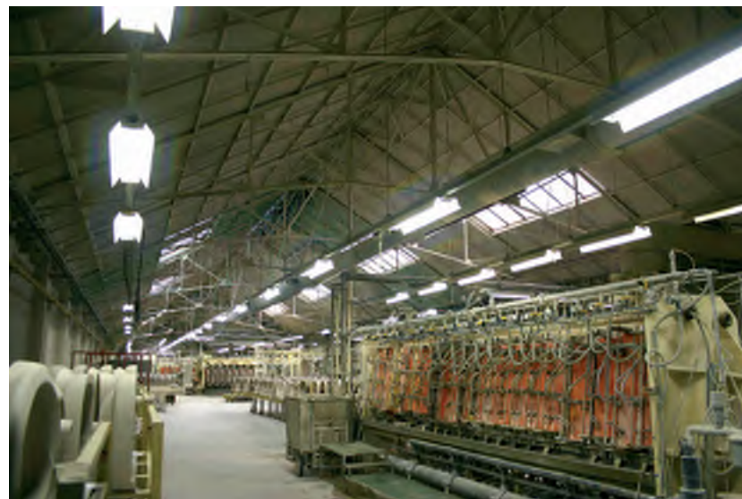
Afb. 81 Overzicht van de kapconstructie van het gebouw 16.
