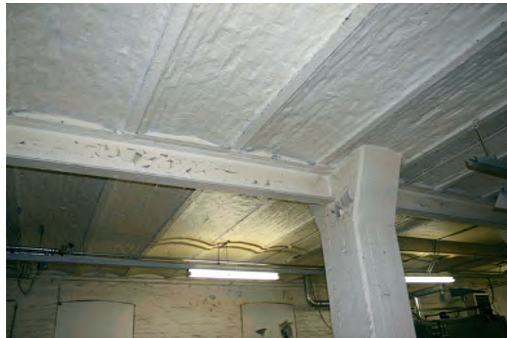
Afb. 46 De draagconstructie van het gebouw 2: betonkolommen, stalen liggers en bakstenen troggewelfjes op staal.
