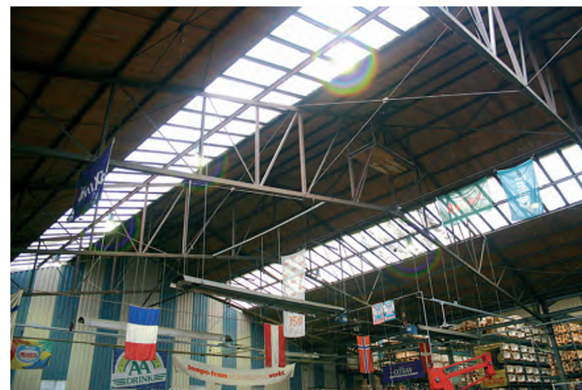
Afb. 44 De kapconstructie van het gebouw 1e.
