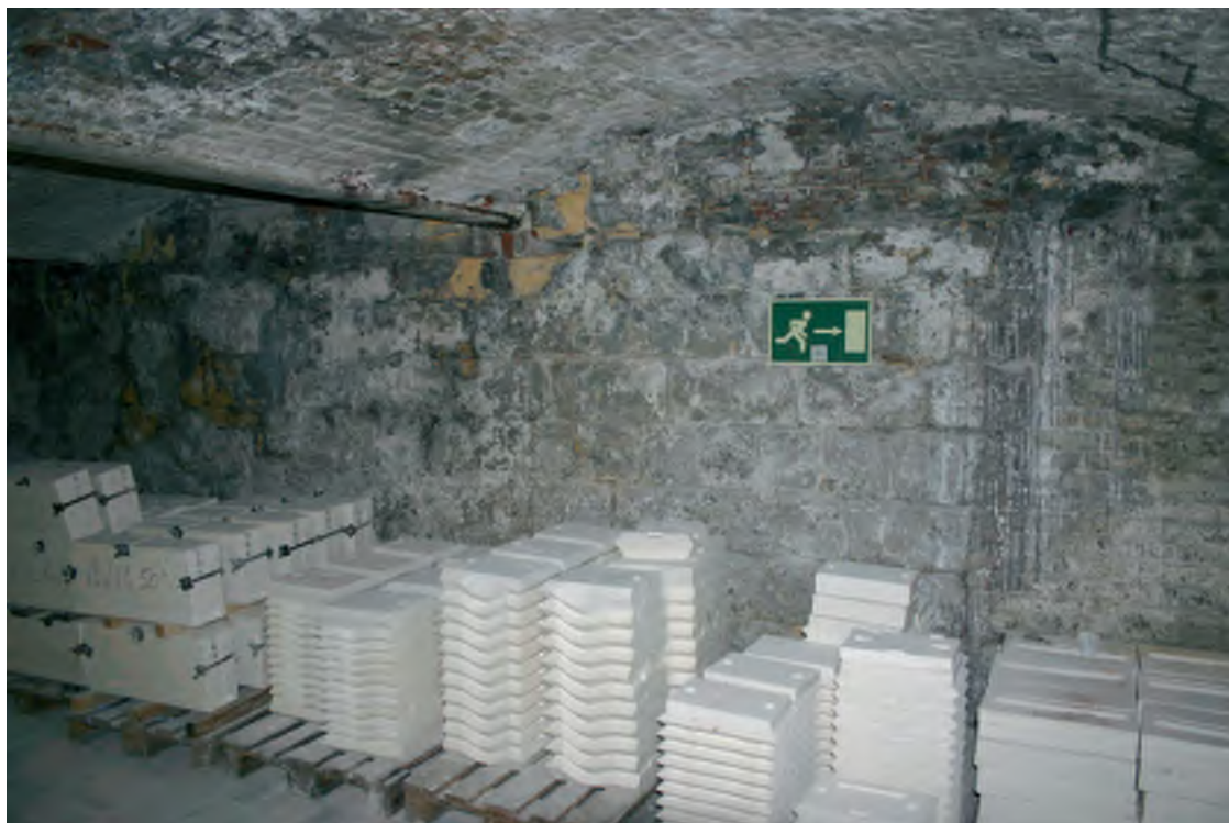
Afb. 40 Zicht op muurwerk in mergelblokken, een restant van een ouder, negentiende-eeuws fabrieksgebouw.
