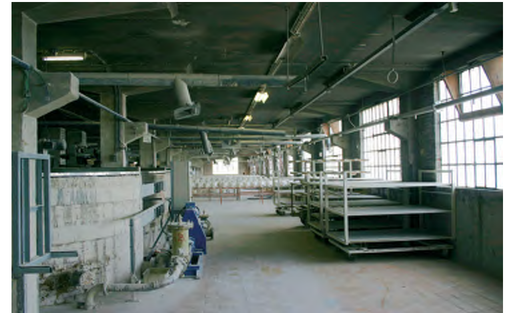
Afb. 70 Een van de verdiepingen van de eerste uitbreiding van het Eifelgebouw, Eiffel II)
