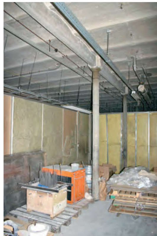
Afb. 52 De draagconstructie van het gebouw 7. Op de begane grond gietijzeren kolommen en gemetselde troggewelfjes op staal.
