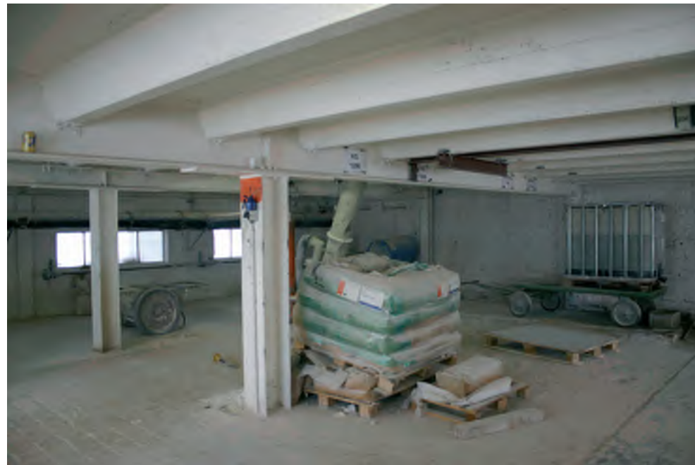
Afb. 112 De stalen draagconstructie met de in beton gestorte vloeren van het gebouw 31.
