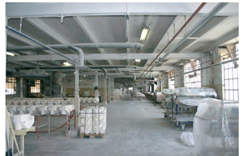
Afb. 71 De staalconstructie van het derde en laatst gebouwde deel van het Eifelgebouw, Eiffel III. Zie ook afb. 64 en 72.
