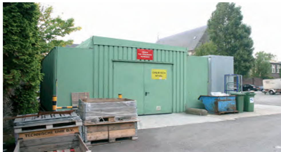
Afb. 140 Exterieur van de opslag voor chemisch afval, gebouw 51.
