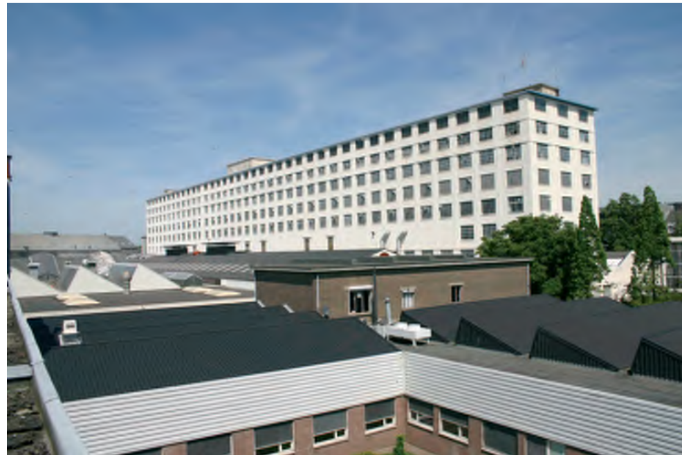
Afb. 67 Het Eifelgebouw gezien vanaf gebouw 7. Met op de voorgrond, gekenmerkt door de sheddakconstructie, het gebouw 4.
