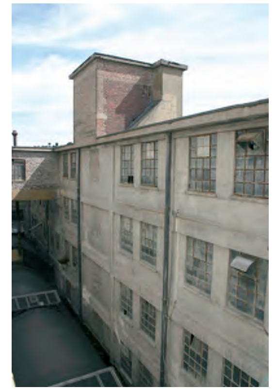
Afb. 123 Een deel van de achtergevel van het gebouw 35 met aansluitend op de gevel een deel van de brug tussen de gebouwen 30 en 35.
