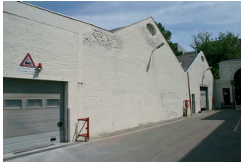
Afb. 79 De kopgevels van de gebouwen 15 en 16.
