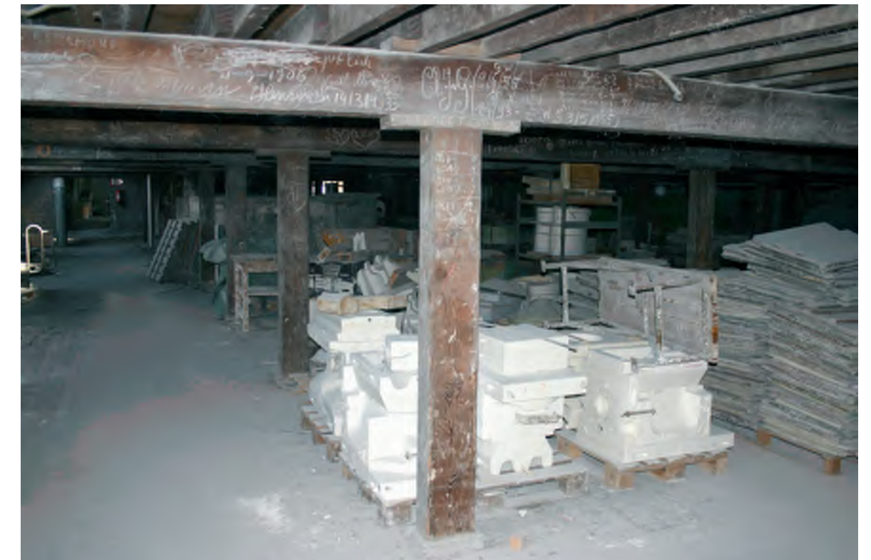
Afb. 92 Een detail van de kapconstructie van het gebouw 21 met in krijt dateringen, namen, initialen en voetbaluitslagen.
