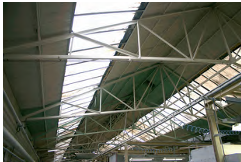
Afb. 80 Een deel van de kapconstructie van het gebouw 15.
