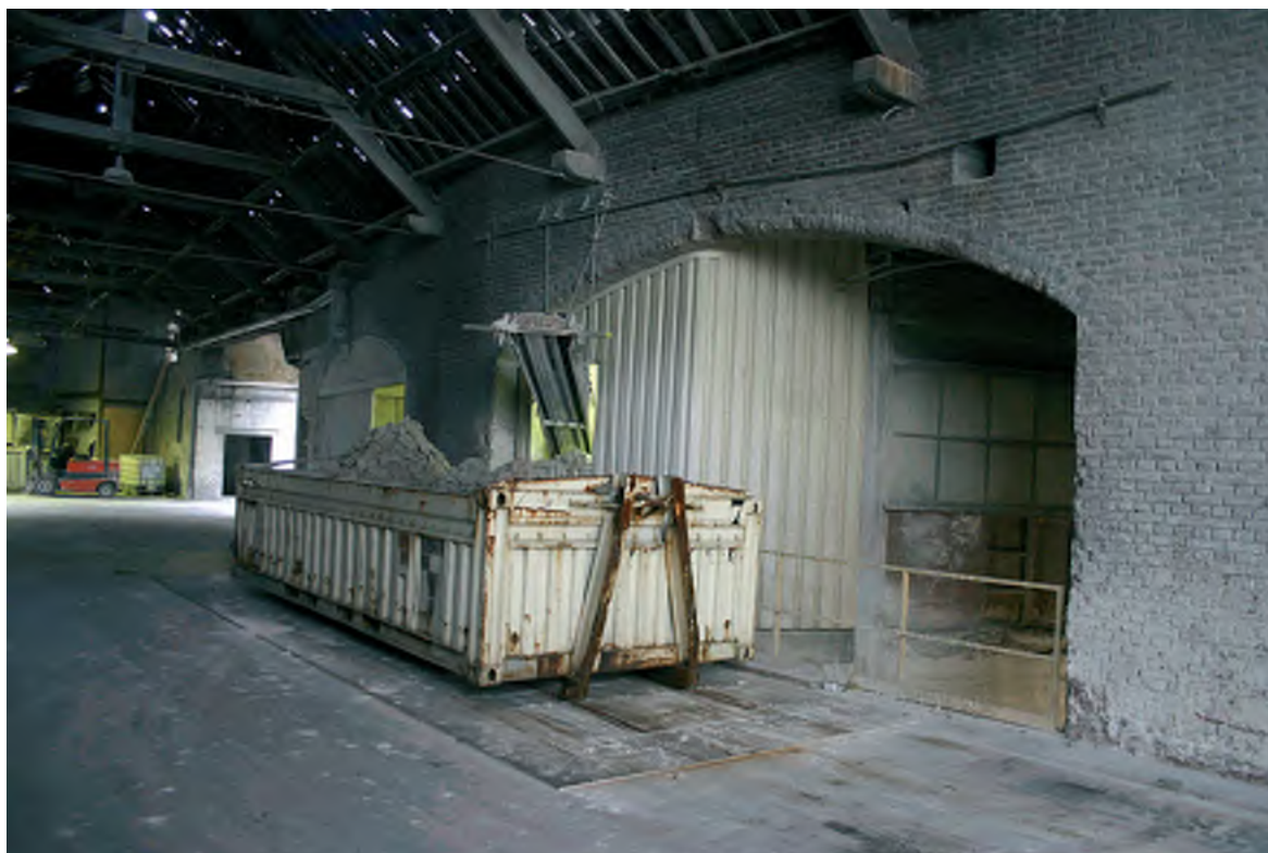
Afb. 103 De gevel van het gebouw 27 gezien vanuit het gebouw 28.
