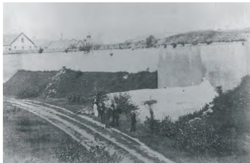
Afb. 9 Zicht op de Lindenkruispoort en de stadsmuur ten noorden van deze poort. Op de achtergrond gebouwen staande op het Sphinxterrein.
