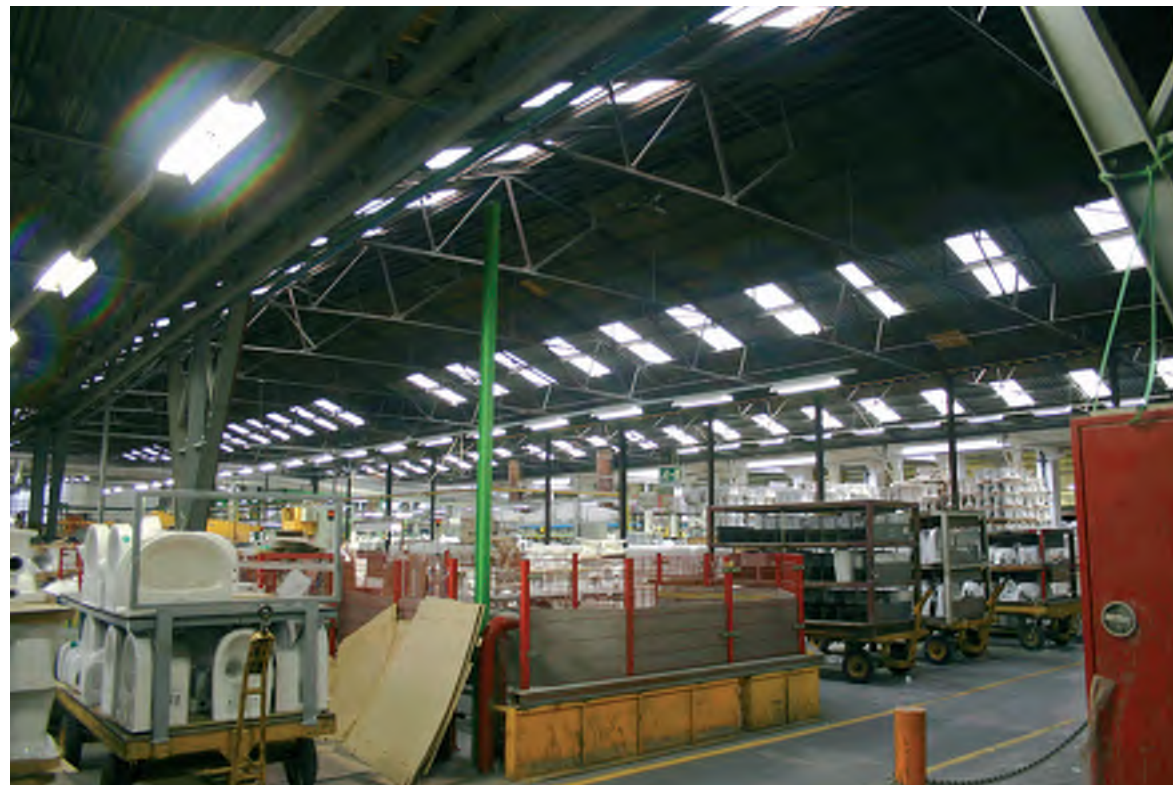
Afb. 60 Een deel van de kapconstructie van de hal 12a, met op de achtergrond de kapconstructie van hal 12b en de betonnen kolommen van het Eiffelgebouw, gebouw 14.
