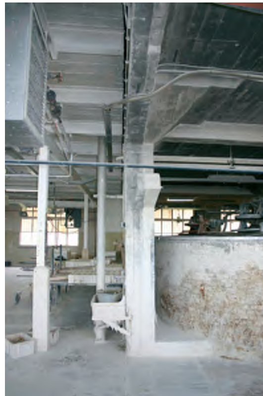
Afb. 72 De aansluiting van de betonconstructie van het oudste deel van het Eiffelgebouw (rechts) en de staalconstructie van de tweede en laatste uitbreiding uit 1941 (links).
