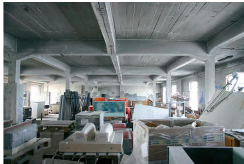
Afb. 111 Het interieur en de constructie van het gebouw 30b met zicht op een deel van de gevel van het gebouw 30.
