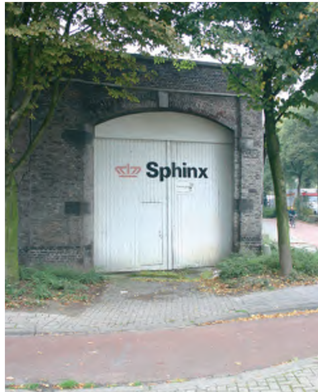
Afb. 104 De op de hoek van de Boschstraat en de Statensingel gerichte voormalige spooringang van het gebouw 28 met in de sluitsteen het jaartal 1873.
