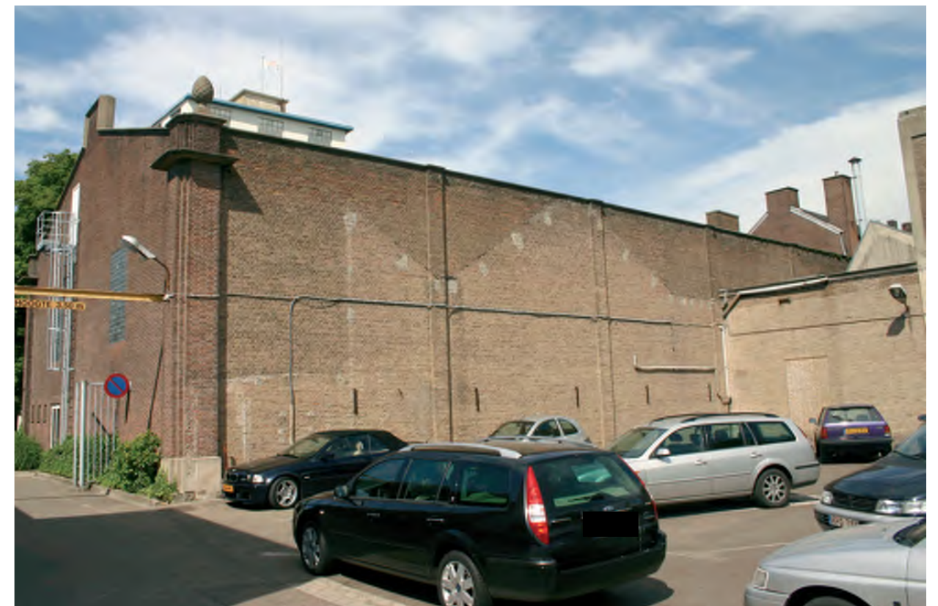
Afb. 130 De achtergevel van het gebouw 38 met daarop aftekeningen van inmiddels verdwenen gebouwen.
