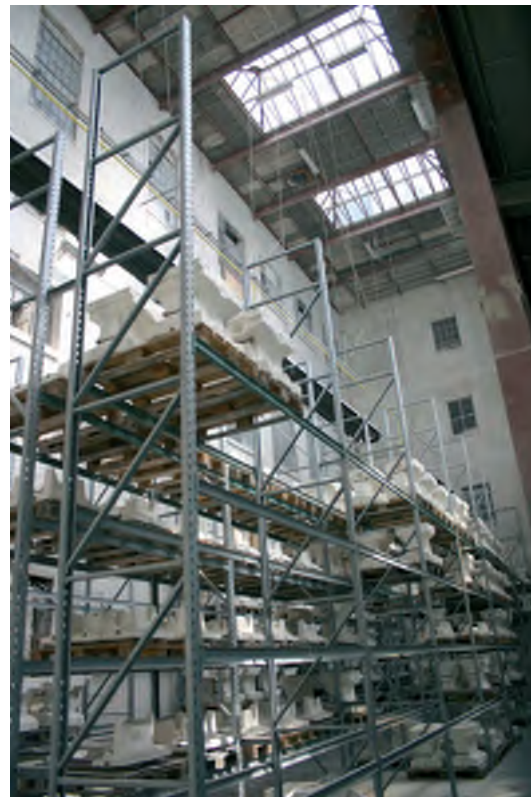
Afb. 109 De betonconstructie van het gebouw 30 van de bovenste verdieping.
