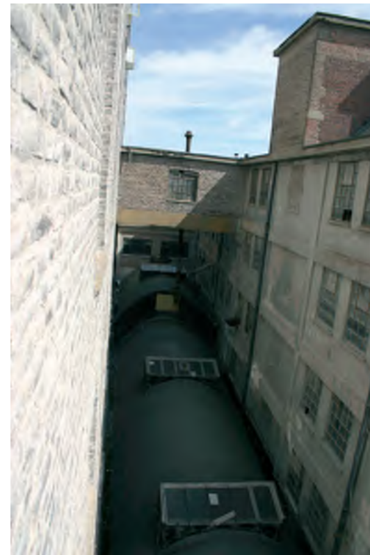
Afb. 115 De overdekte straat, gebouw 32, gezien vanuit gebouw 31. Rechts op de foto de 'achtergevel' van het gebouw 35.
