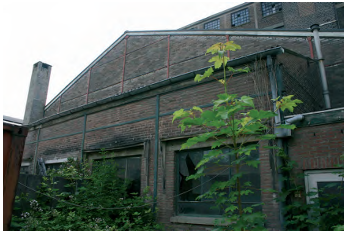
Afb. 132 Het exterieur van het gebouw 43.
