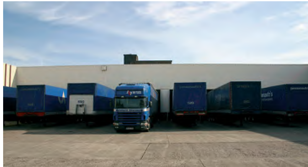
Afb. 134 Het exterieur van het gebouw 44.
