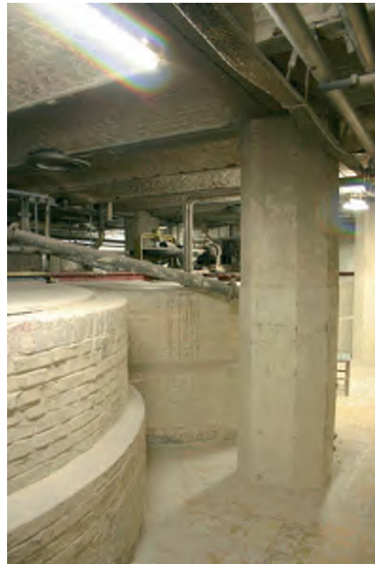
Afb. 107 De betonconstructie van het gebouw 30 in de kelder.
