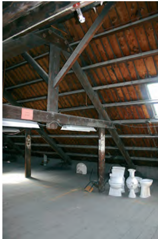
Afb. 55 De bovenste zolder van het gebouw 7 met zicht op een deel van één van de spanten van de kapconstructie.
