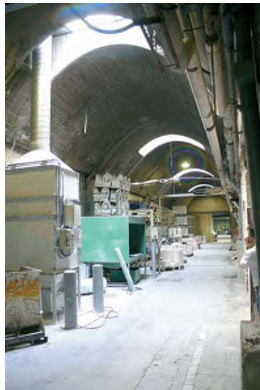
Afb. 114 Een blik in de overdekte straat, gebouw 32, gezien vanuit gebouw 17.
