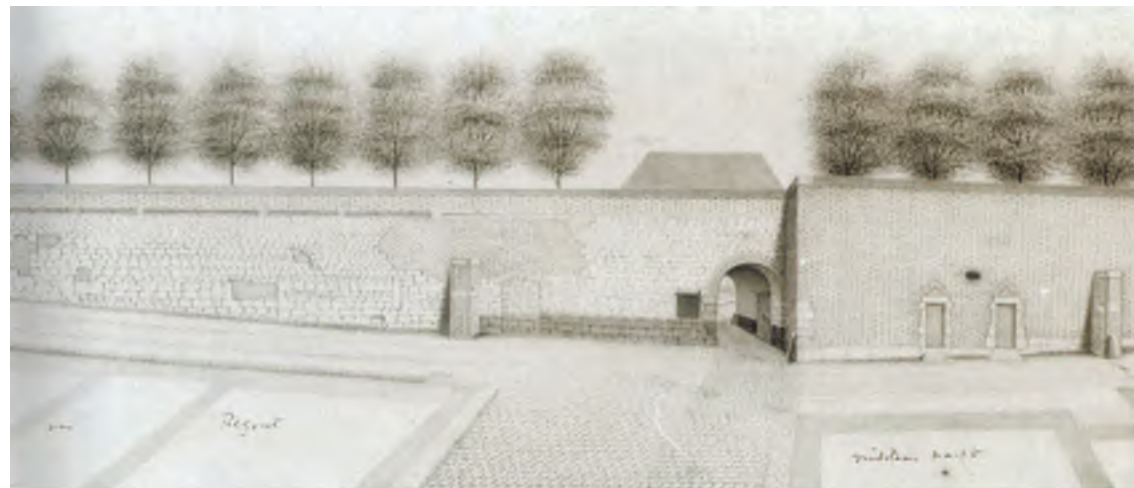
Afb. 8 Zicht op de Boschpoort en aangrenzende verdedigingsmuur vanuit de stad gezien. Links op de voorgrond een perceel dat aangeduid is als zijnde eigendom van Regout.
