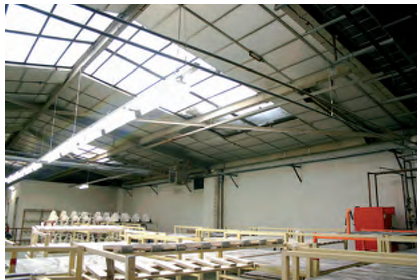
Afb. 85 Een deel van de kapconstructie van het gebouw 18. De muur rechts is de gevel aan de Boschstraat.
