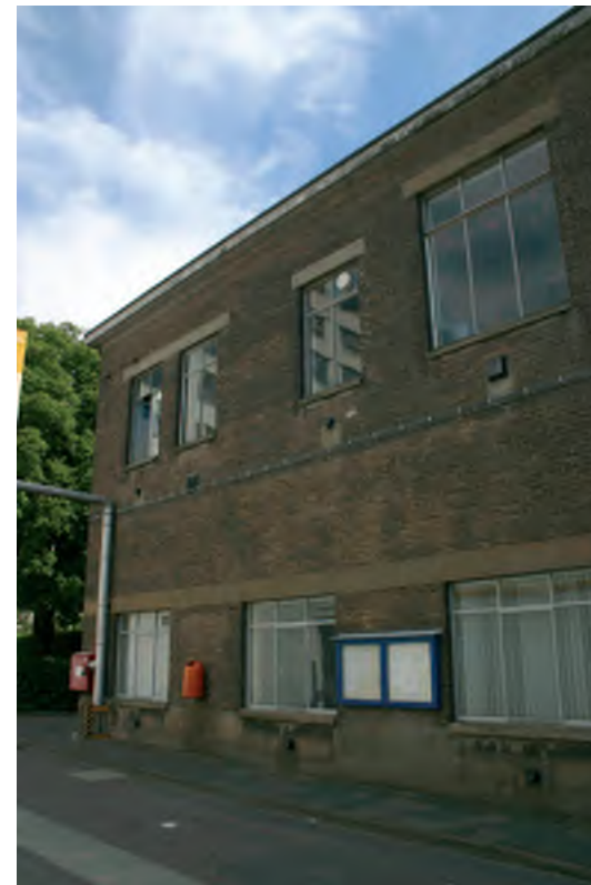
Afb. 49 Een deel van de gevel van het gebouw 5.
