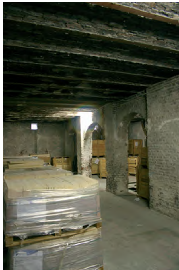
Afb. 117 Gebouw 33 op de begane grond met een troggewelfde verdiepingsvloer met stalen liggers.
