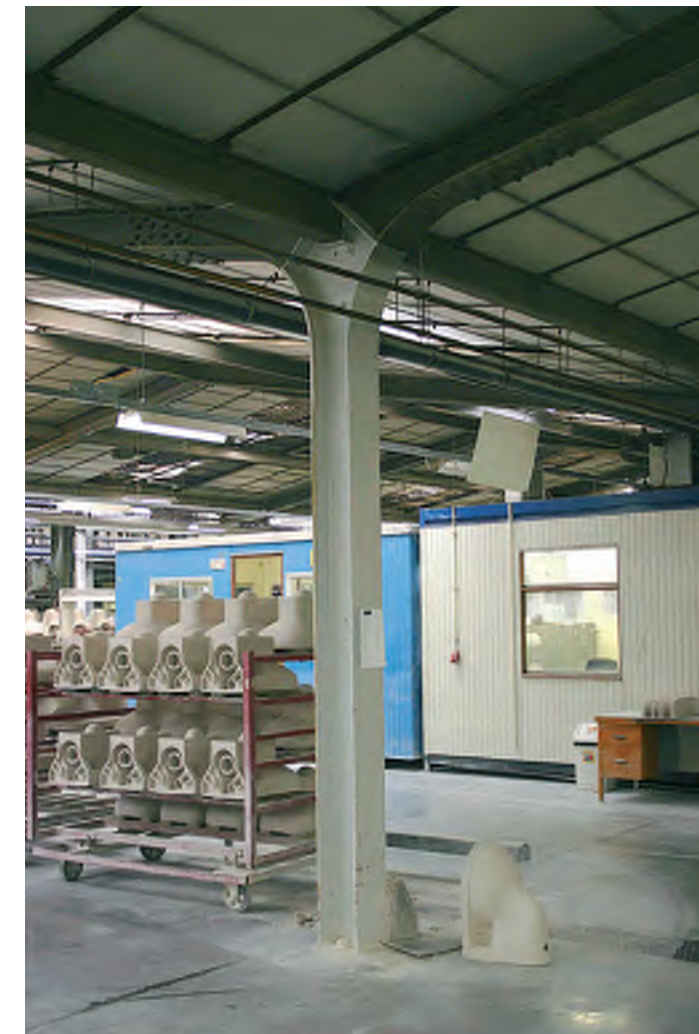
Afb. 86 De aansluiting van de kapconstructies van de gebouwen 17 en 18.
