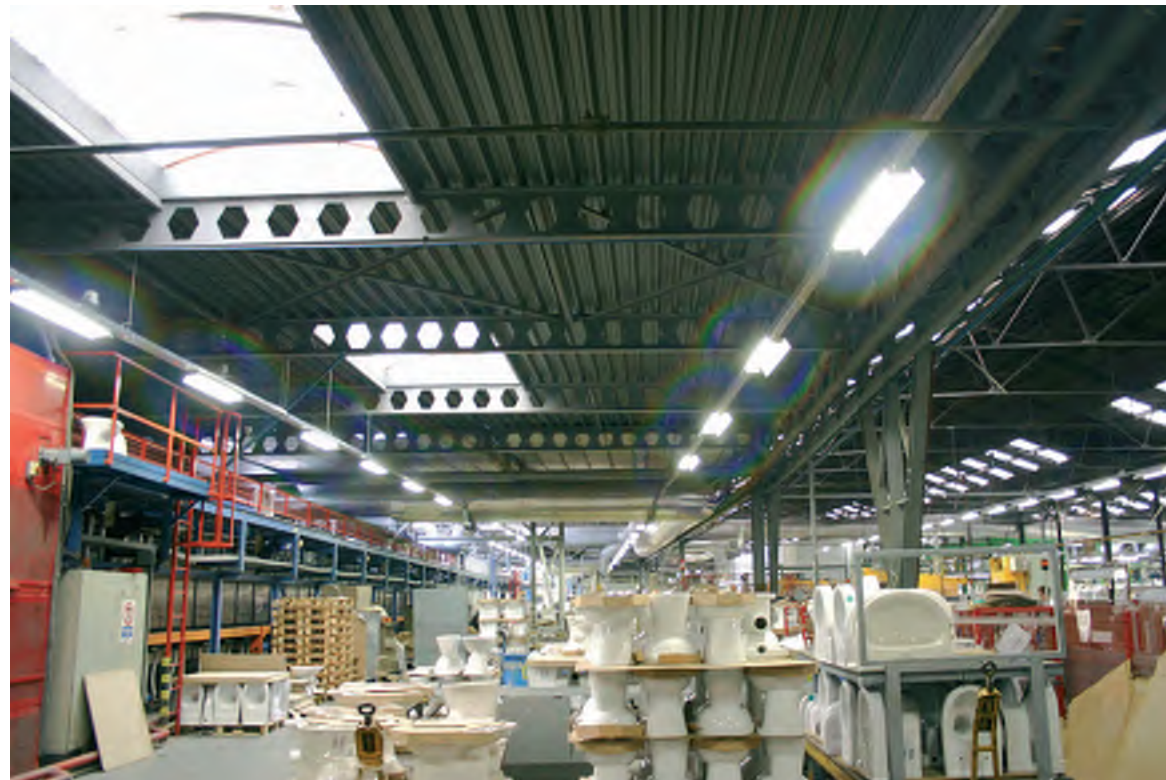
Afb. 59 Een deel van de dakconstructie van de hal 11c met rechts aansluitend op deze hal een deel van de kapconstructie van gebouw 12.
