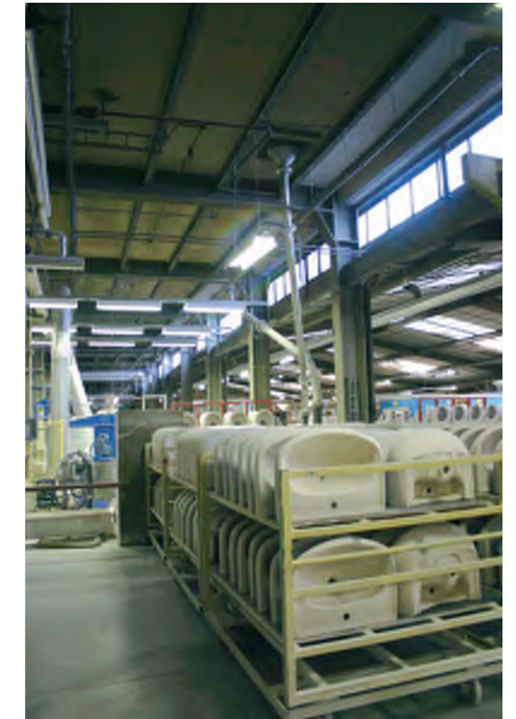
Afb. 75 De staalconstructie van het derde en laatst gebouwde deel van het Eiffelgebouw. Rechts op de foto een deel van het aansluitende gebouw 13.
