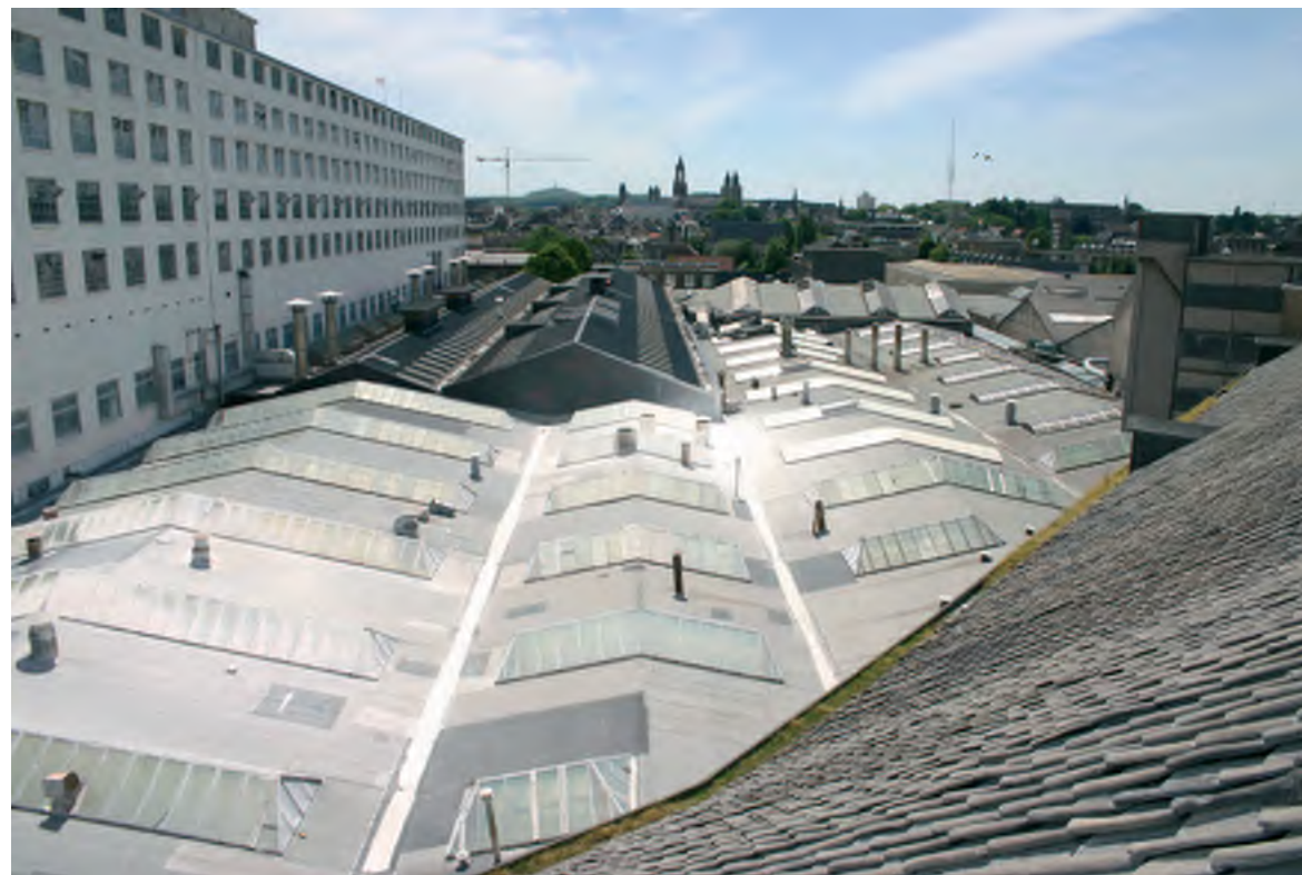
Afb. 35 Kappenoverzicht gezien vanuit het gebouw 22, met links op de foto het Eiffelgebouw.
