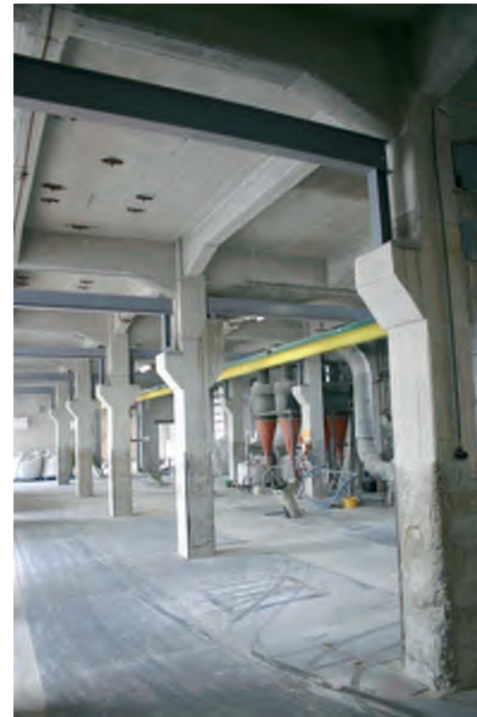
Afb. 108 De betonconstructie van het gebouw 30 op de verdieping.
