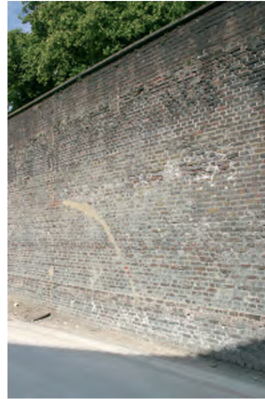
Afb. 37 Detail van de muur die een groot deel van het terrein omsluit.
