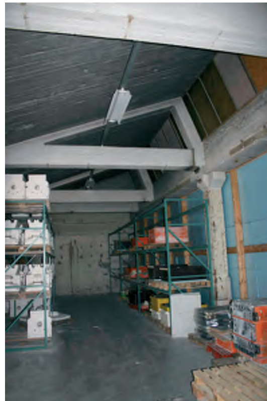
Afb. 48 De betonnen draagconstructie van het gebouw 4b.
