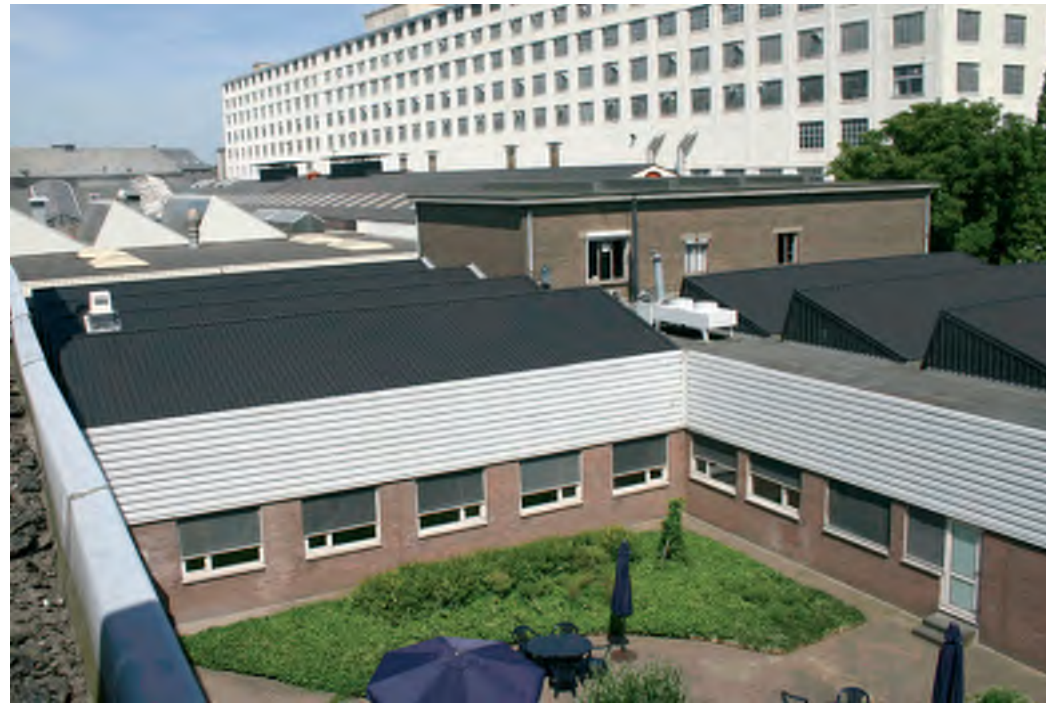
Afb. 47 Gebouw 4 gezien vanuit gebouw 7. Het bouwdeel met het platte dak is gebouw 5.
