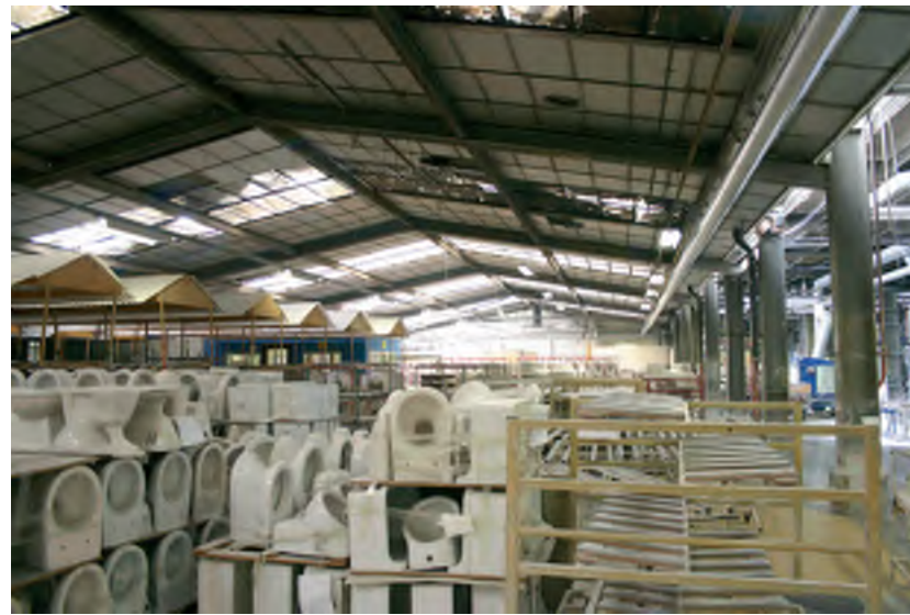
Afb. 83 De kapconstructie van het gebouw 17.
