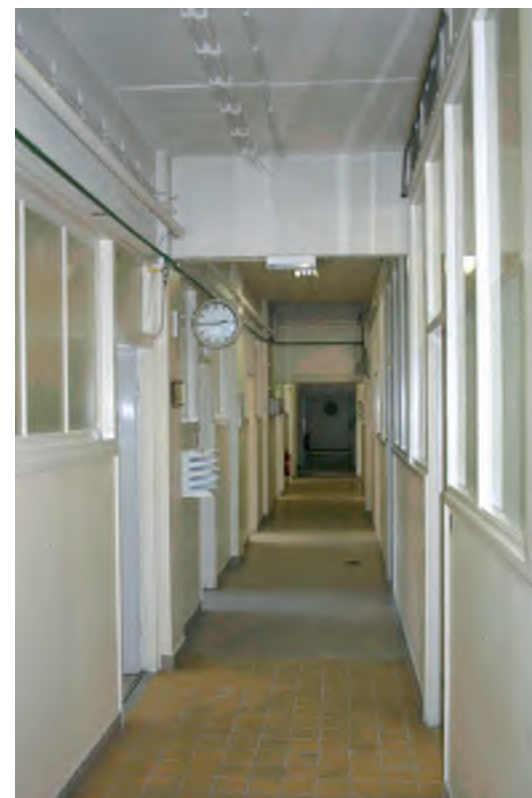
Afb. 53 Het interieur van de verdieping van het gebouw 7.
