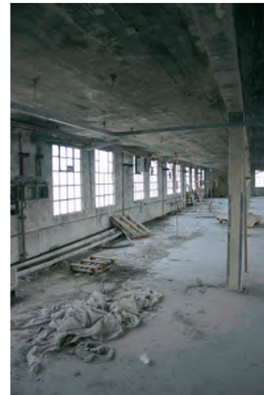
Afb. 122 De betonconstructie en de regelmatige vensterindeling van het gebouw 35 op de bovenste verdieping.
