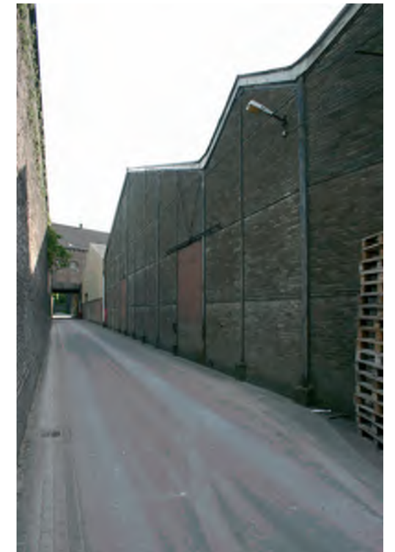
Afb. 41 De naar de Statensingel gerichte gevels van de fabriekshallen (gebouw 1) met op de achtergrond het gebouw 6 en het gebouw 8, met een doorgang. Links op de foto de muur die het terrein grotendeels omsluit.
