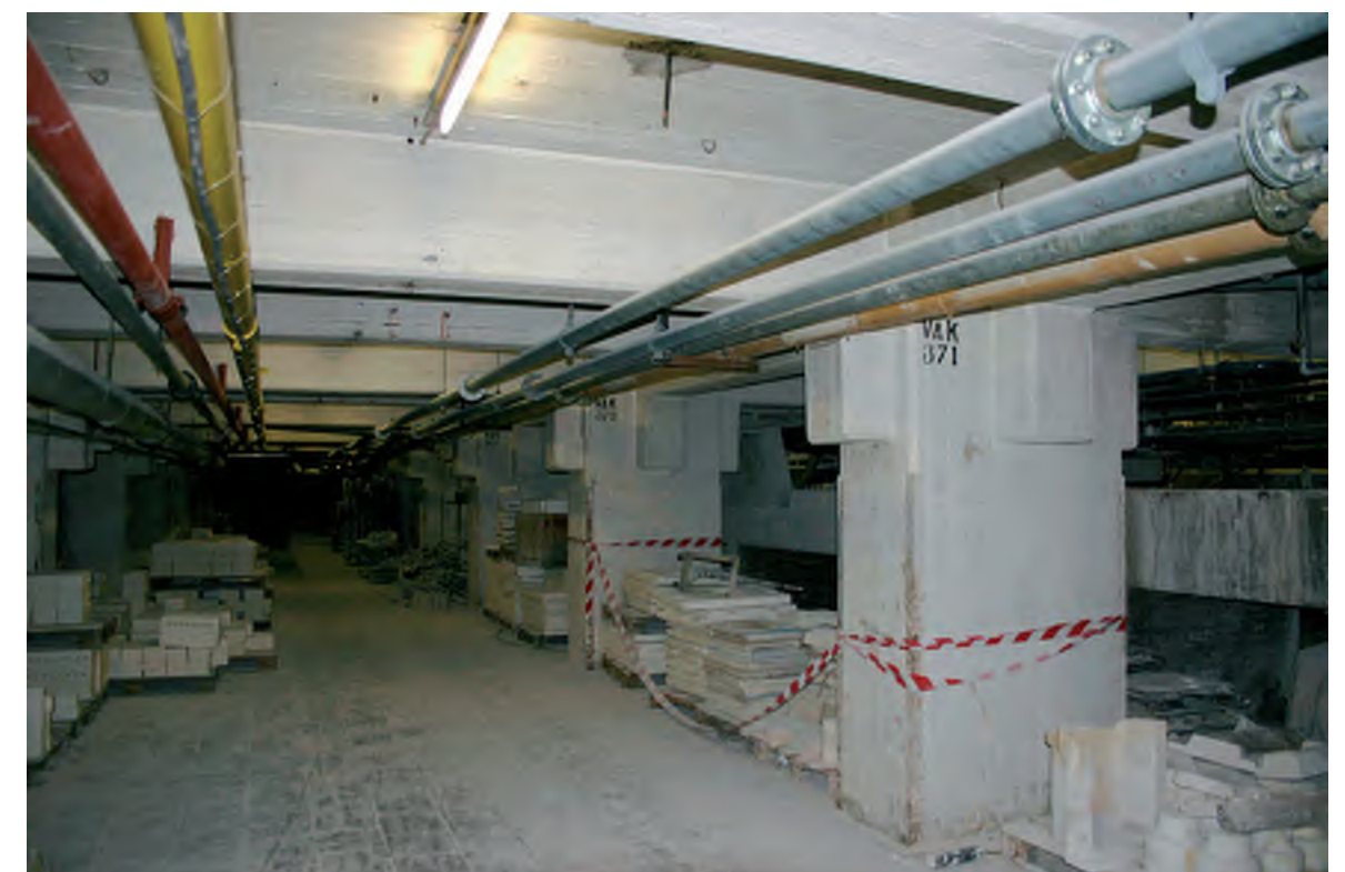
Afb. 77 De betonconstructie van de kelder onder het jongste deel van het Eiffelgebouw.
