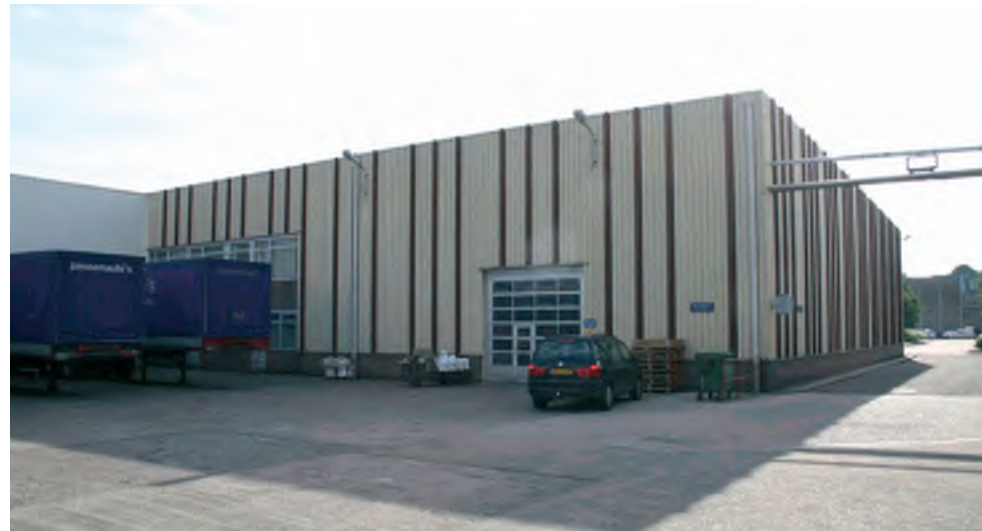
Afb. 135 Het exterieur van het gebouw 45.
