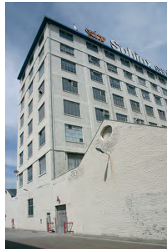
Afb. 62 Het Eiffelgebouw (gebouw 14a) met op de voorgrond de kopgevel van het gebouw 15. Het Eiffelgebouw is op de begane grond breder dan op de verdiepingen.
