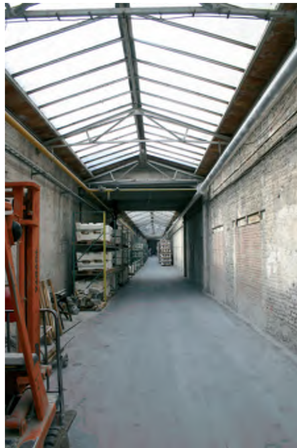
Afb. 58 Een overzicht van de overdekte straat, gebouw 9c, gezien in de richting van het gebouw 8.
