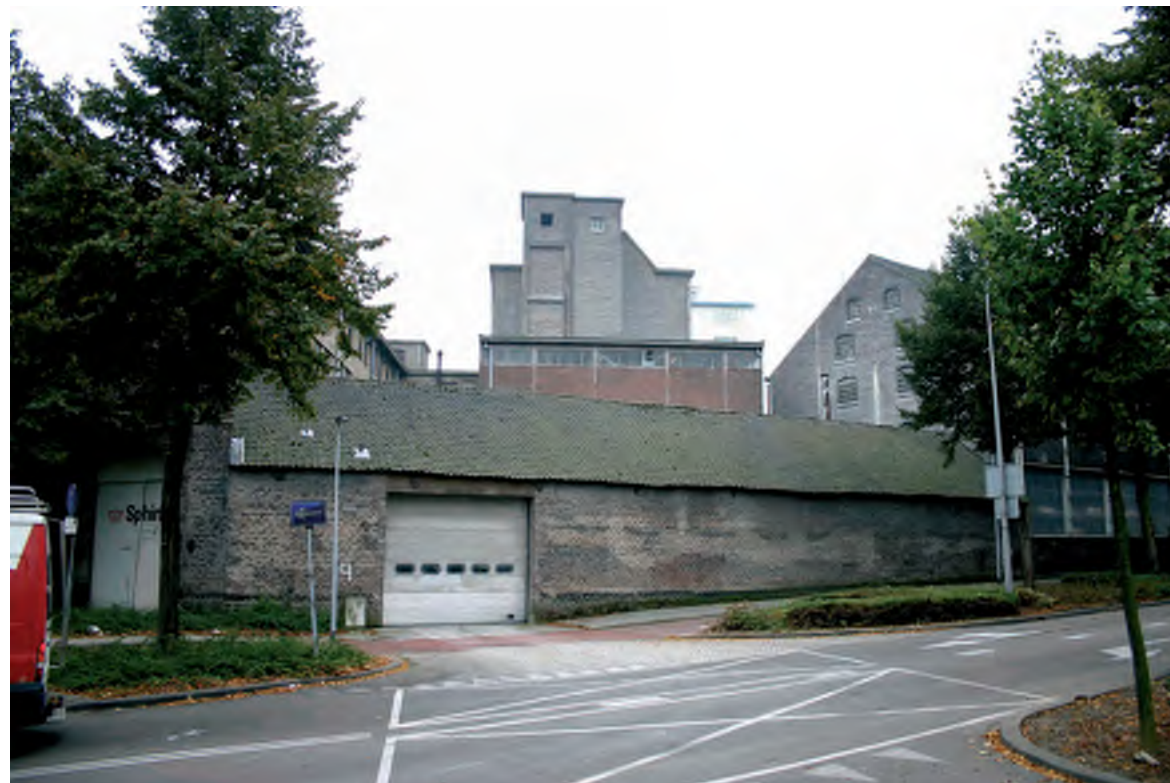
Afb. 105 De op de Statensingel gerichte gevel van het gebouw 28 met daarachter een deel van de straatgevel van het gebouw 26 waarboven een deel van het gebouw 30 uittorent.
