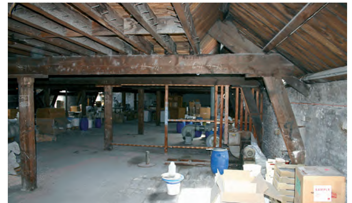
Afb. 54 Een deel van de kapconstructie van het gebouw 7.
