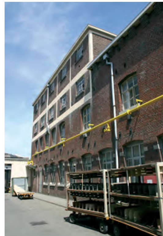
Afb. 51 De voorgevel van het gebouw 7 waarop duidelijk de bouwphase, de ophoging van gebouw 7b in beton, te zien is.
