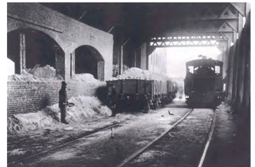
Afb. 24 Aanvoer van grondstoffen per spoor.
