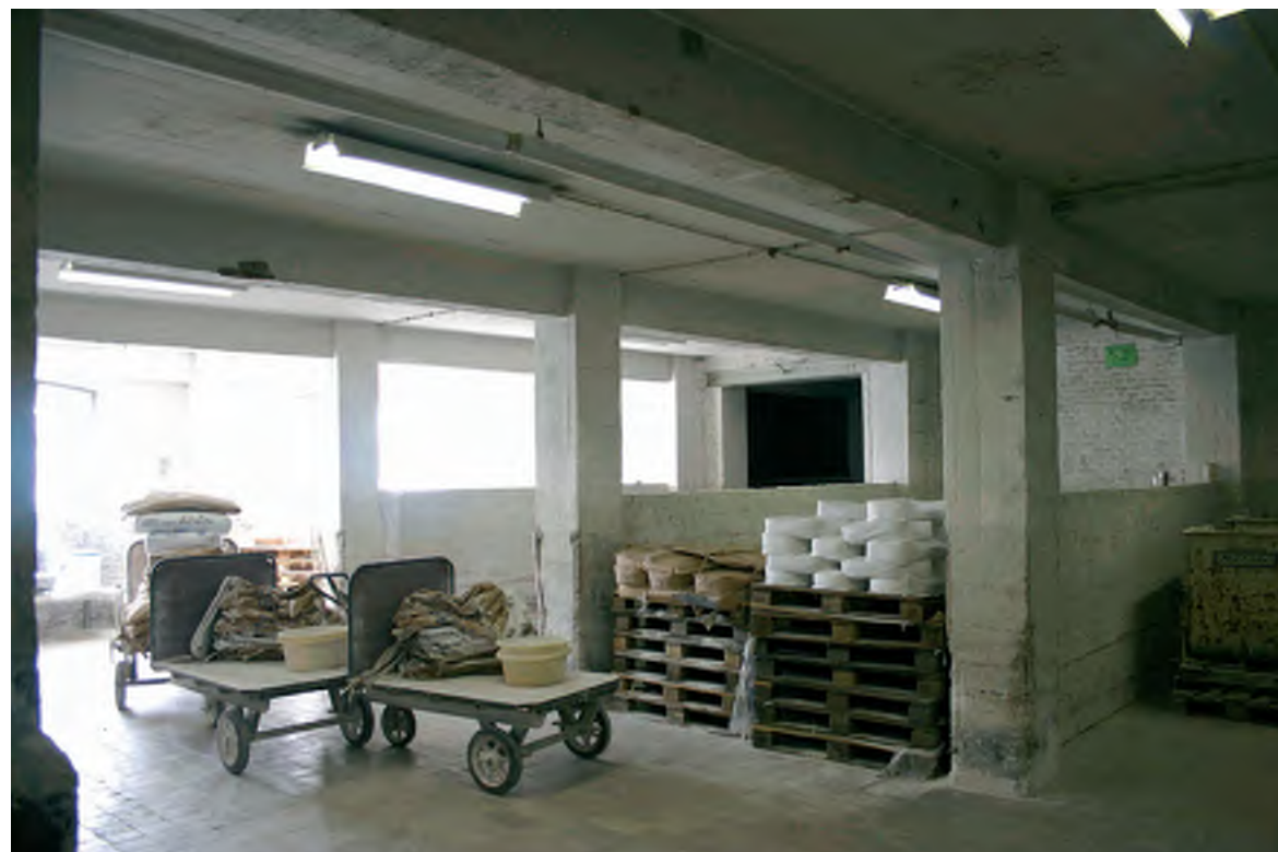
Afb. 120 De betonconstructie van het gebouw 35 gezien op de begane grond.
