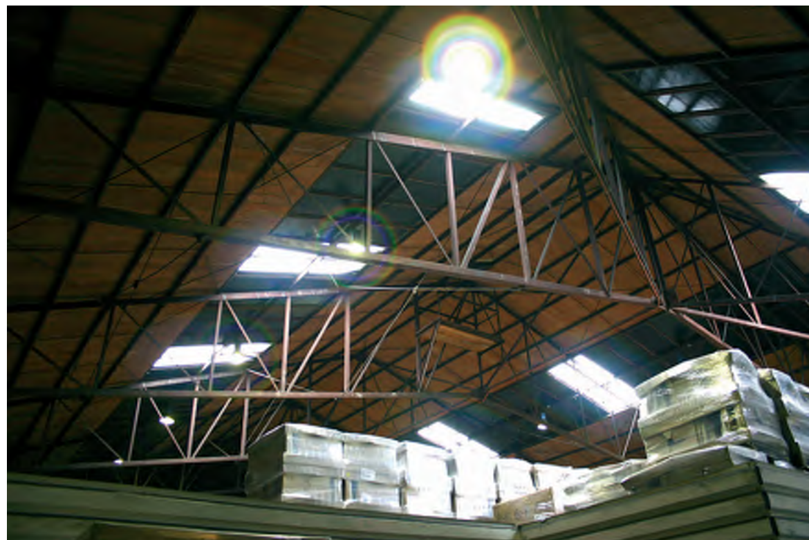
Afb. 42 Zicht op de kapconstructie van de hal 1a.
