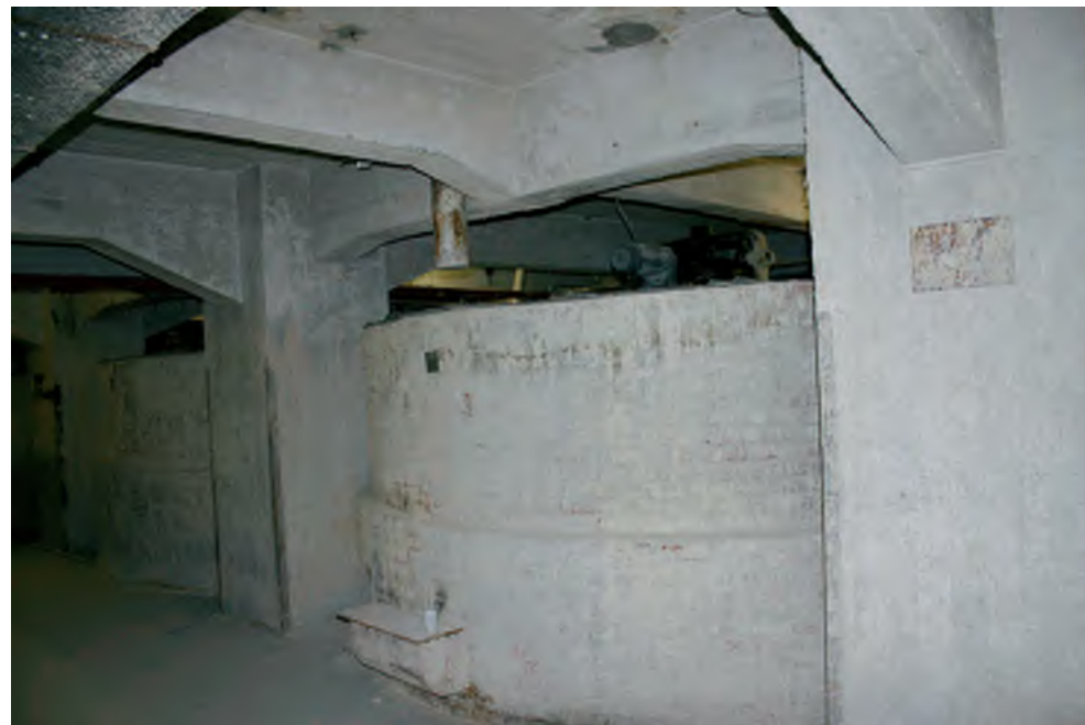
Afb. 68 De betonconstructie van de kelder onder het oudste deel van het Eifelgebouw.
