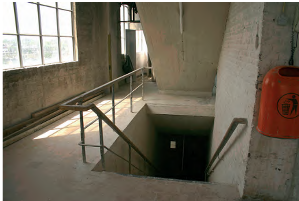
Afb. 76 Een oorspronkelijke trap die niet zoals vele is voorzien van een gemetselde ombouw.
