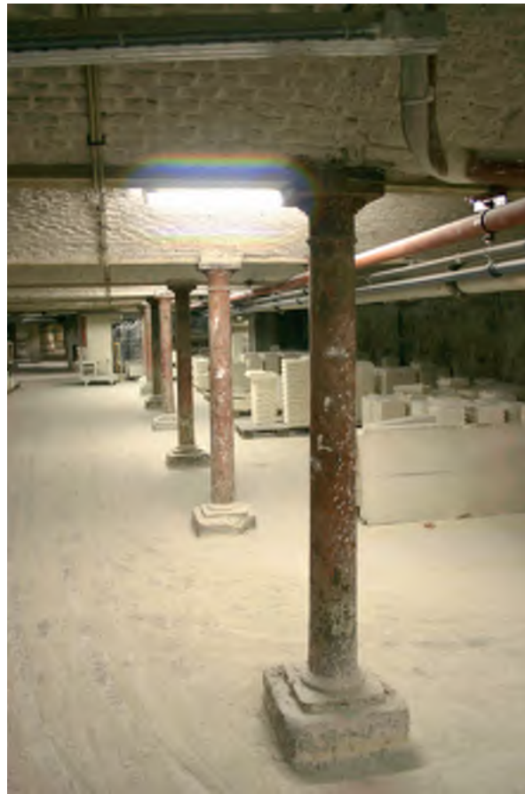
Afb. 39 De oudere troggewelfde kelder onder het gebouw 13. IJzeren kolommen met daarover stalen liggers waartussen troggewelven zijn gemetseld.
