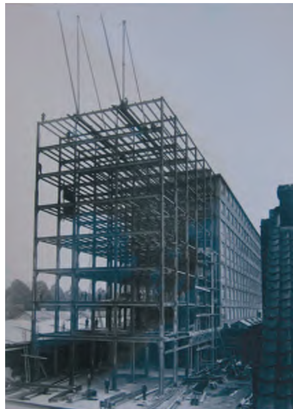
Afb. 64 Het staalskelet ten behoeve van de uitbrei- ding van het Eifelgebouw. Eiffel III (1941).
