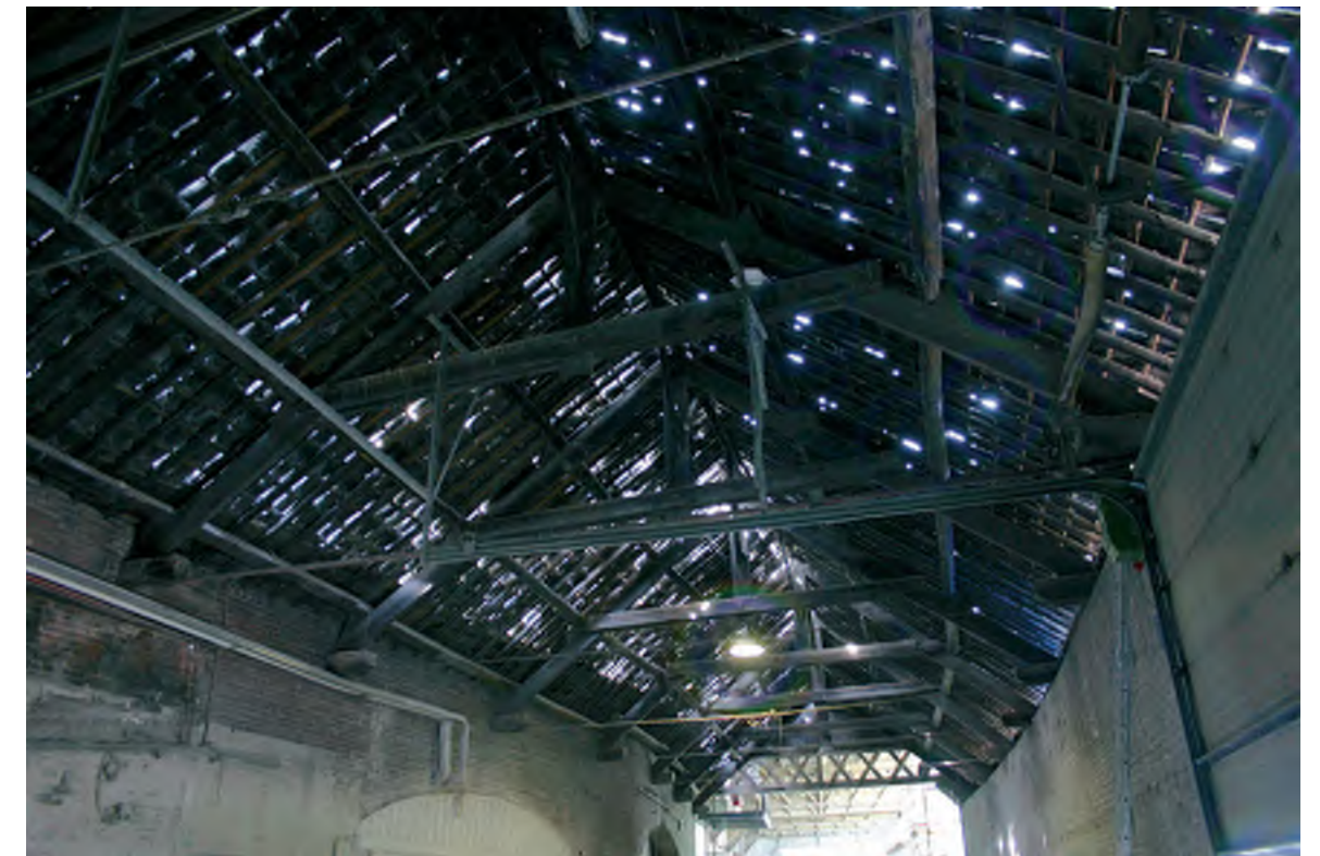
Afb. 106 De kapconstructie van het gebouw 28 waarin ouder materiaal is hergebruikt.
