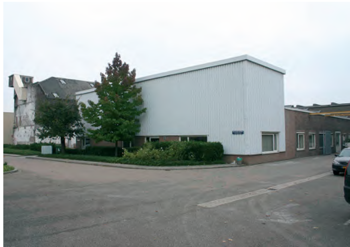
Afb. 131 Het exterieur van het gebouw 39.
