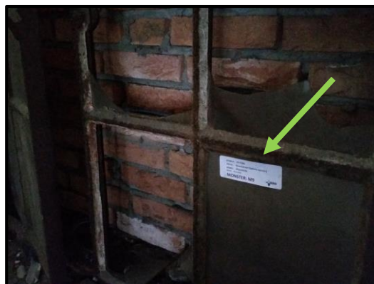
M6, M8 en M9 – Stopverf in stalen kozijnen is in dit geval niet asbesthoudend.
