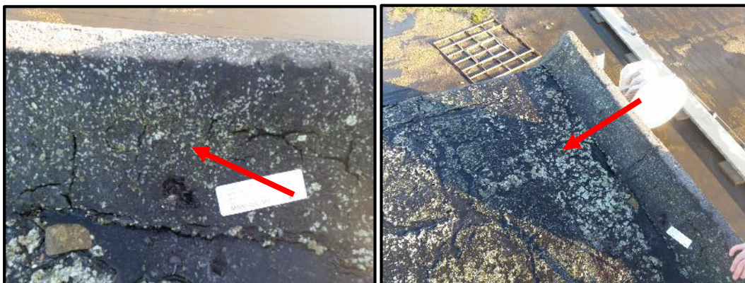
Bron 2/M2: bitumen dakbedekking dakopbouw, asbesthoudend.
