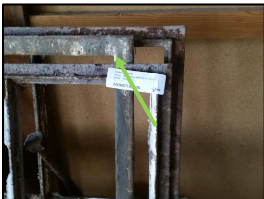
M6, M8 en M9 – Stopverf in stalen kozijnen is in dit geval niet asbesthoudend.
