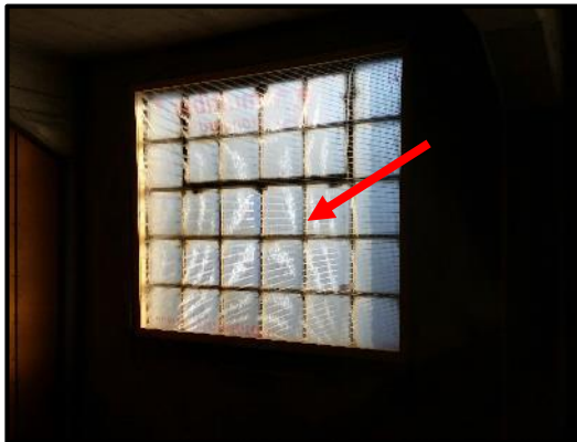
Bron 6/M7: stopverf stalen gevelkozijnen, asbesthoudend.
