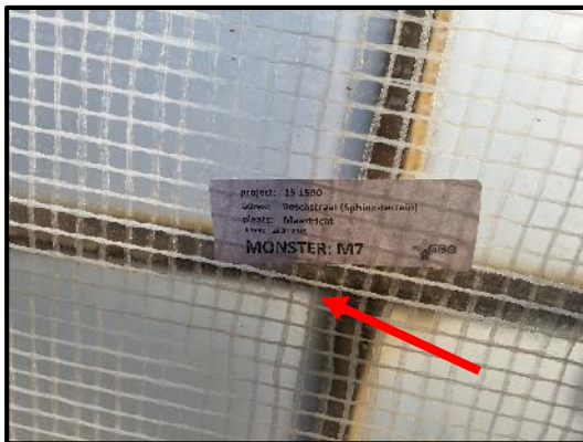
Bron 6/M7: stopverf stalen gevelkozijnen, asbesthoudend.
