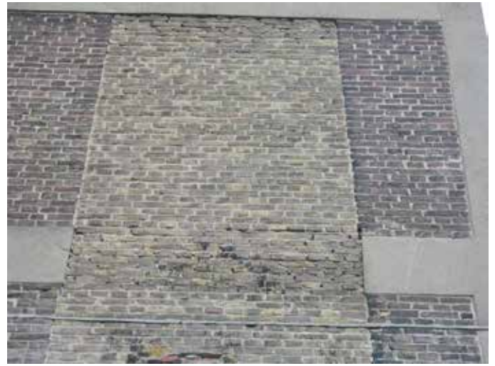
26. Duidelijk is dat de opening dateert uit de tijd van de ophoging, gelet op de afgewerkte zijkanten van de betonnen balk
