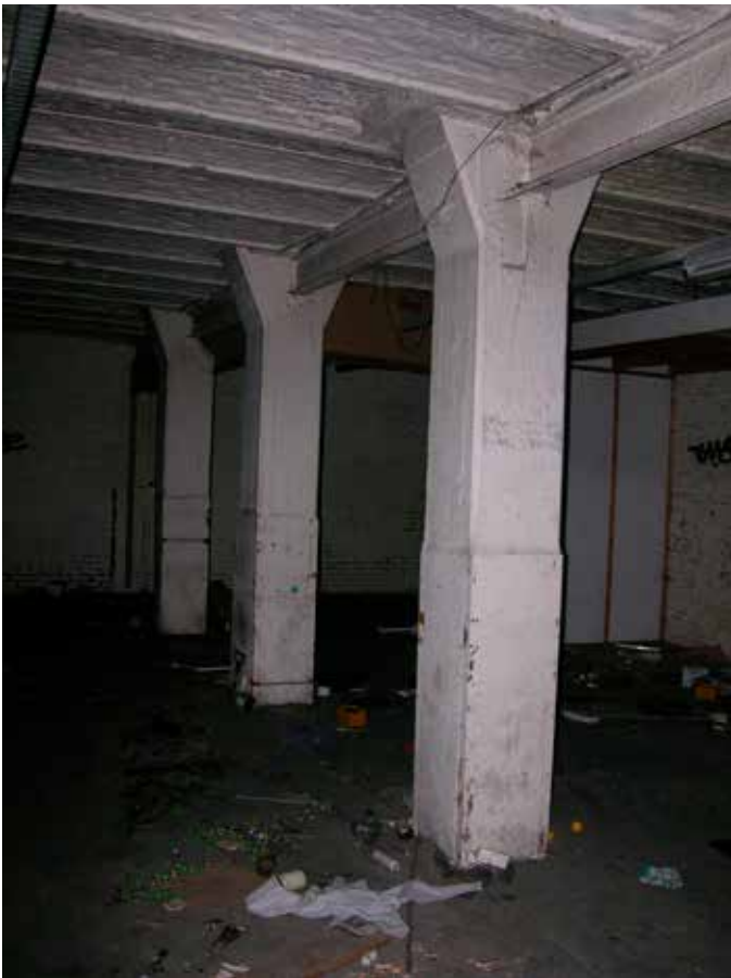
40. De constructie bestaat uit betonnen kolommen die verbonden zijn met ijzeren h-balken. Daarop rusten ijzeren profielen met tussengeplaatste troggewelfjes in baksteen, een voor de bouwtijd, 1875, zeer gebruikelijke oplossing. De benedenstukken van de kolommen zijn gepleisterd
