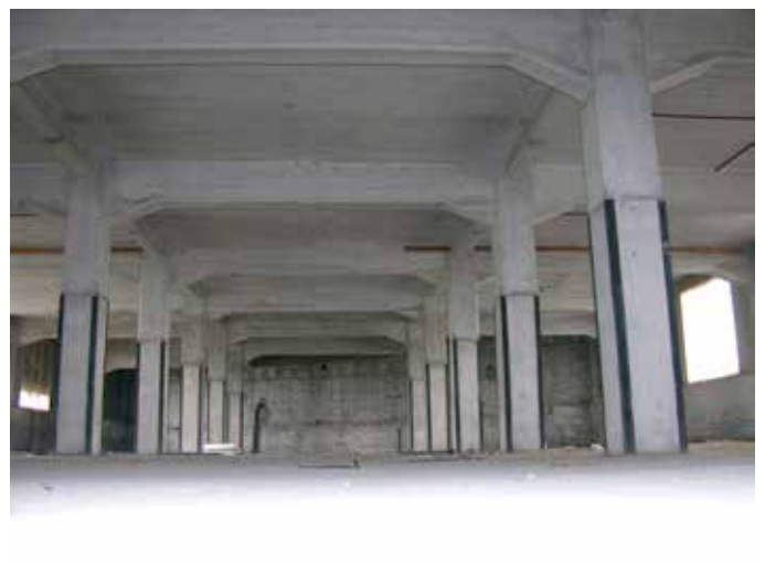
71. De ruimte naar het noorden gezien. Het plafond bestaat uit beton
