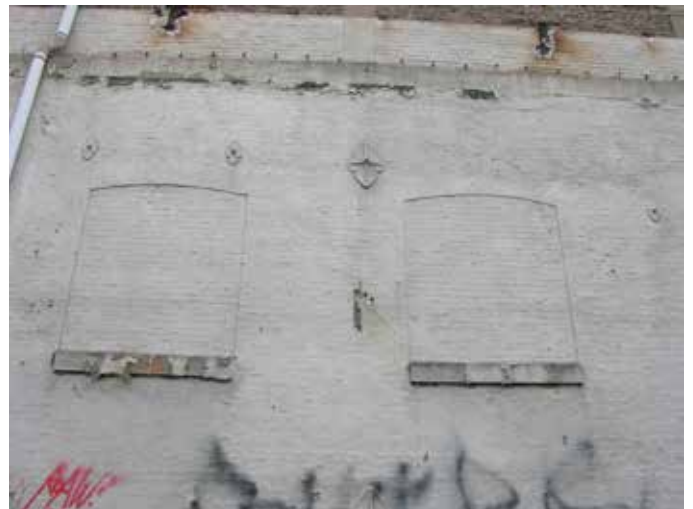
23. Aan deze kant zaten wel op beide niveau's vensters, die allemaal zijn dichtgezet
