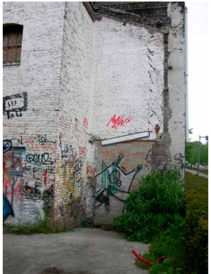
19. De dichtgezette vensters van de koker verwijzen naar de vensters van het trappenhuis
