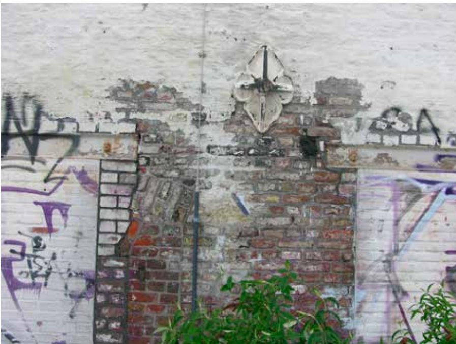
13. Een rij gaten in het bovenste segment verwijst naar een verdwenen dak of vloer
