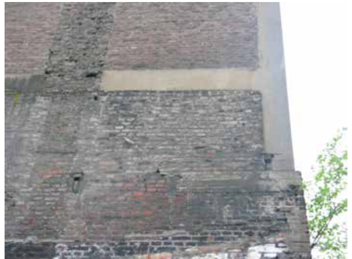
14. Ook op de hoek met de westgevel een stuk betonnen balk als aanzet voor de uitbreiding
