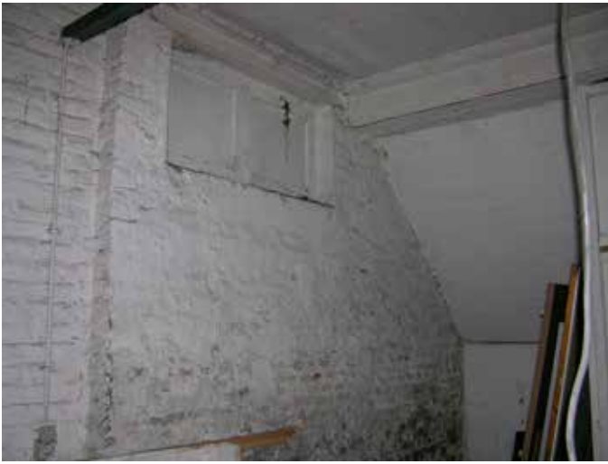
38. Onder de trap zit een gedicht venstertje in de zuidgevel
