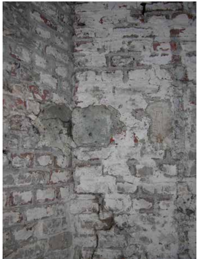
55. Ook hier is, ten overvloede, te zien hoe de noordgevel koud tegen de andere gevel staat
