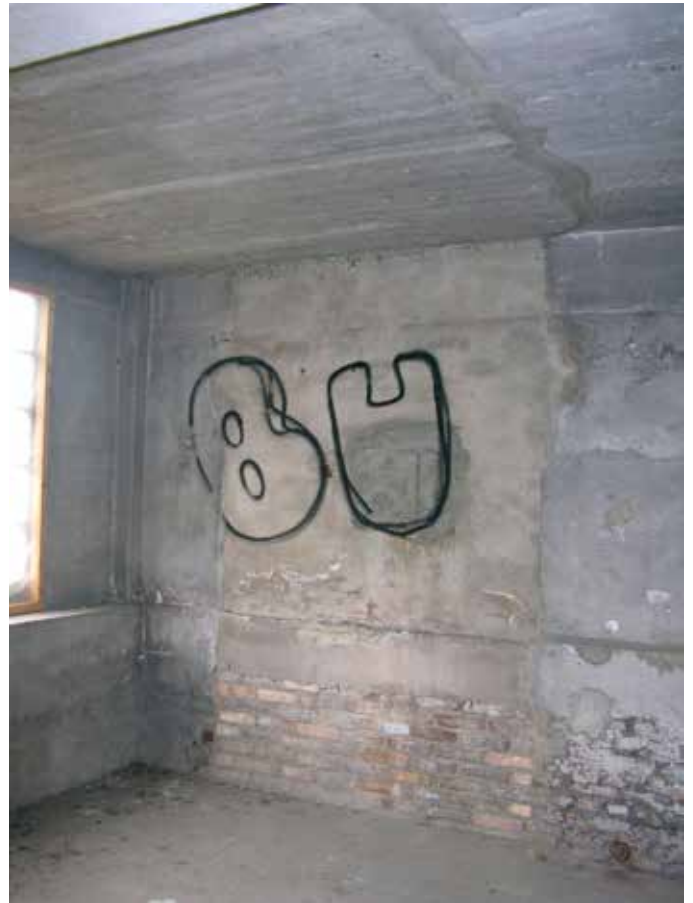
69. De voormalige grote opening in de zuidgevel
