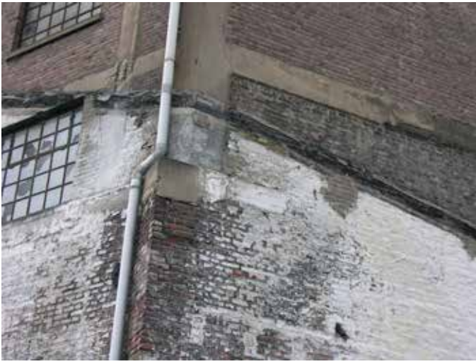
11. De hoek van de t.o.v. de Brikkenbouw schuin staande noordgevel laat zien waar de ophoging uit 1923 begint. Voor de aanzet daarvan zijn stukken betonbalk gestort. De uitbreiding heeft en zichtbaar betonskelet
