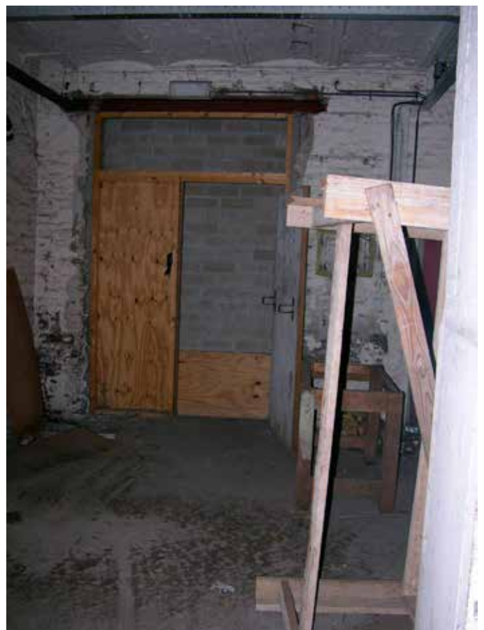
33. De dichtgezette deur naast de liftkoker
