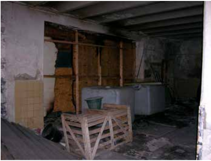
42. In de westgevel zit een grote geblindeerde deur, die naar een lichte hellingbaan leidt die is gecementeerd
