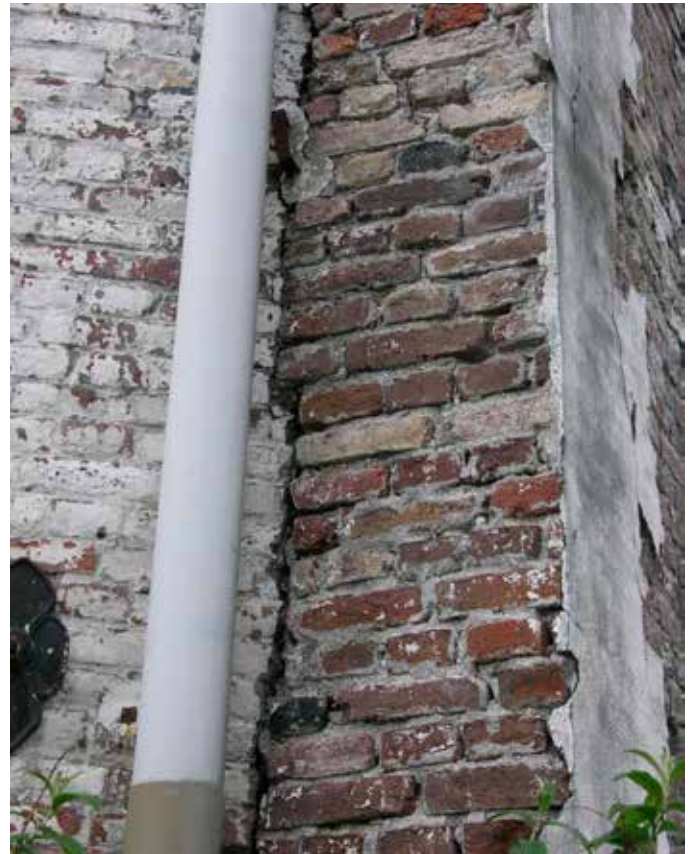
8. De noordgevel staat helemaal los van de rest van het gebouw. Het is niet duidelijk wat de oorspronkelijke buitenkant was, als die er was. Het kan ook zijn dat het een tussenwand is. Opvallend is wel dat de baksteen van de Brikkenbouw precies dezelfde is, en vermitseld op gelijk niveau, als die van de noordgevel
