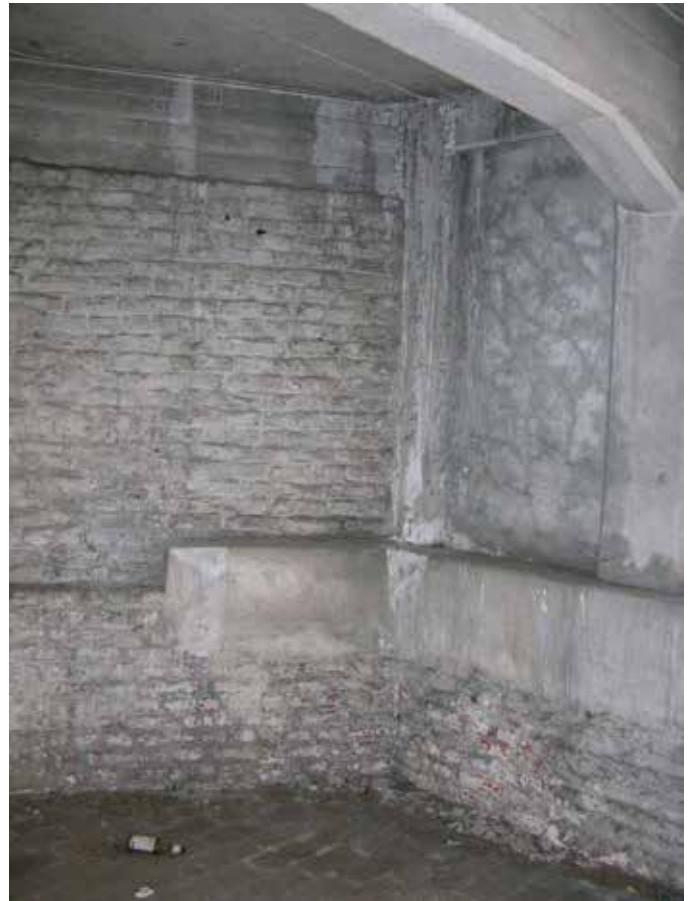
73. Het fragment van de funderingsbalk in de noordoost-hoek van de noordgevel, ter wille van het betonskelet van de ophoging
