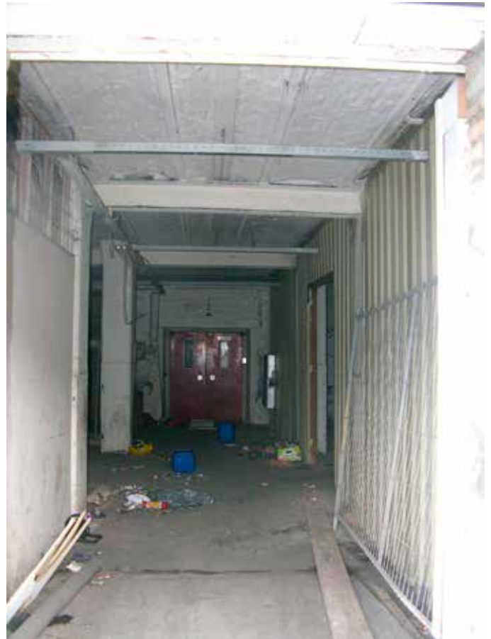
31. De huidige entree van het gebouw met op het eind de liftschacht
