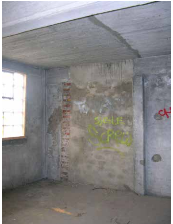
79. Ook hier nog een spoor van de grote opening in de zuidgevel
