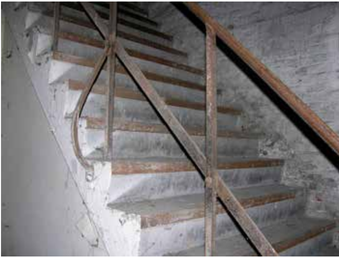
47. De verbindingen zijn met bouten aan elkaar gezet
