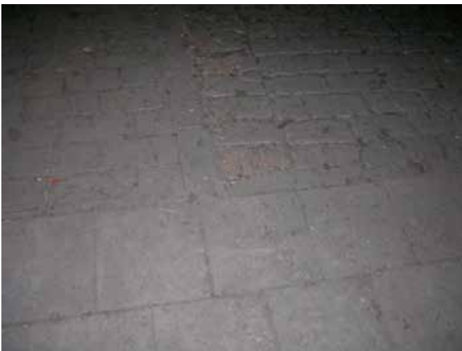
51. De vloer bestaat meteen na aanlanding van de trap, en voor de lift, uit tegels, maar verder uit op hun kant liggende baksteen. Langs de rand van oost- en noorgevel ligt een rand van baksteen ter breedte van een ruime anderhalve meter. Daar zijn de stenen sterk gesleten. Wat daar de oorzaak van is is niet duidelijk
