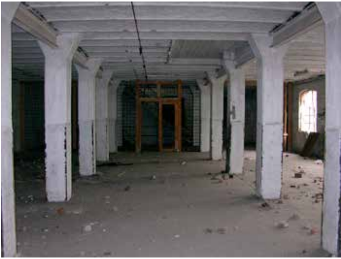
64. De rest van het plafond heeft zijn oorspronkelijke ribben met gewelfjes
