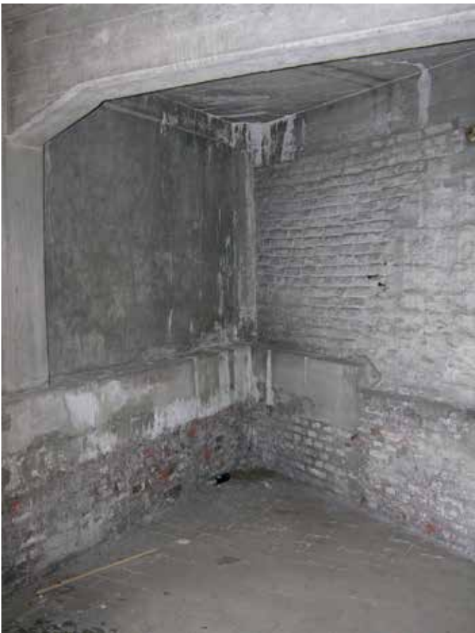
74. Ook aan de andere kant is die te zien. De balk loopt niet door, en ligt op het niveau van de voormalige hoogte van de oorspronkelijke gevel
