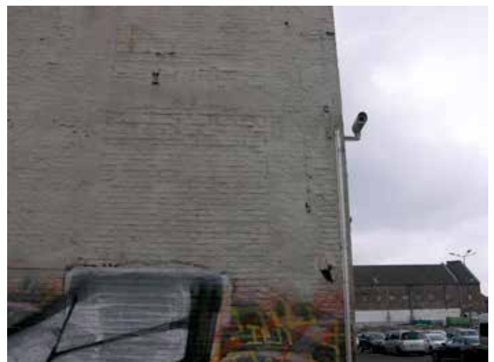
24. Op de zuidoosthoek zijn sporen van een aanbouw te zien
