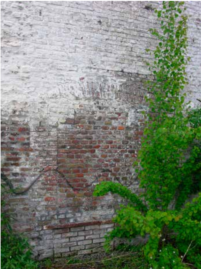
7. Veel grotere openingen hebben ijzeren onderdorpels, wat er wijst dat het doorgeefluiken waren, en geen vensters of deuren
