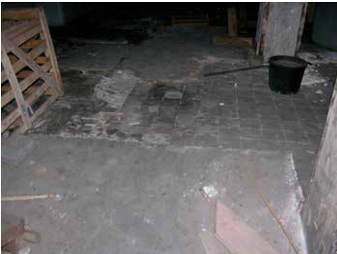
44. Die ruimte heeft een vloer van cementtegels
