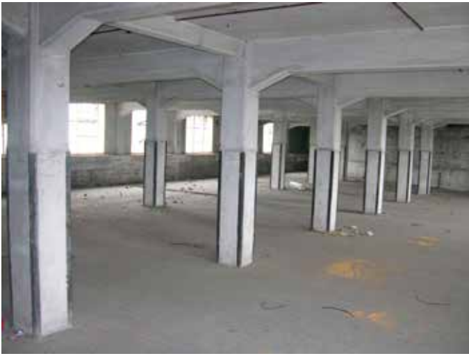
72. De kolommen zijn beschermd door ijzeren hoekprofielen
