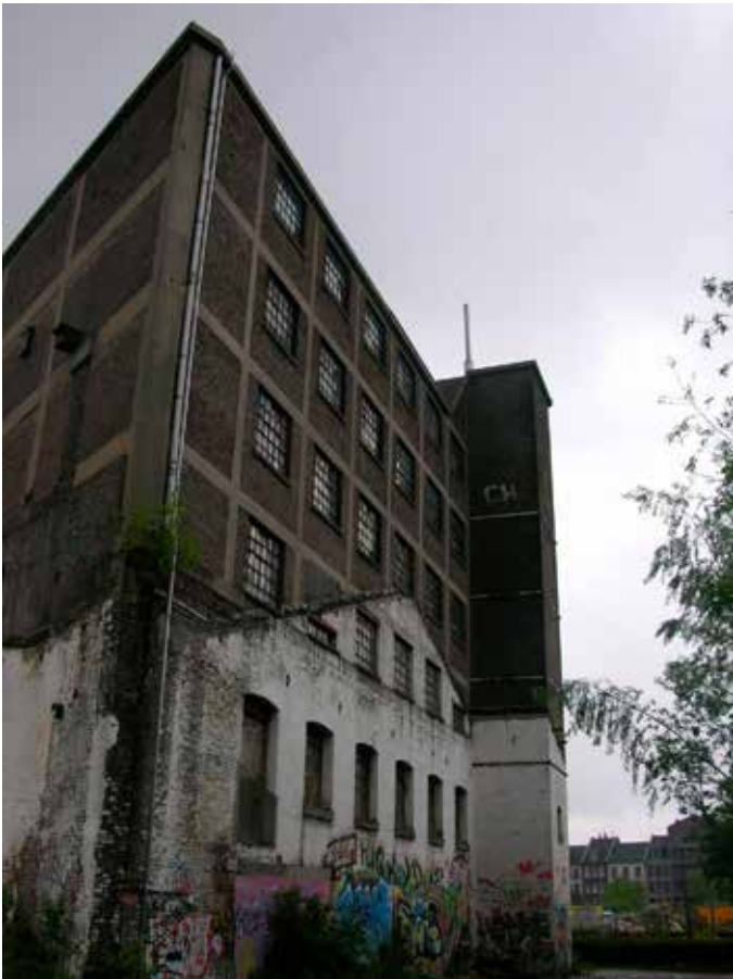
16. De westgevel. De vensters op de begane grond zijn allemaal dichtgemetseld. Op de eerste verdieping zijn ze wel aanwezig, met vierkante onderdorpels van Naamse steen. Op de verdiepingen uit 1923 zijn die platter van vorm.
