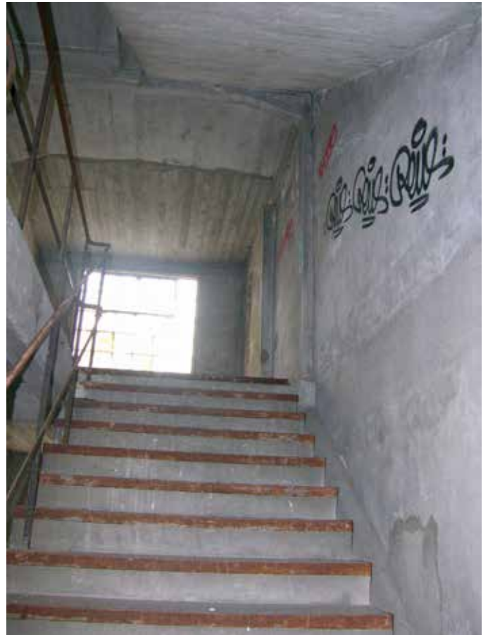
77. Zicht op de vierde bouwlaag
