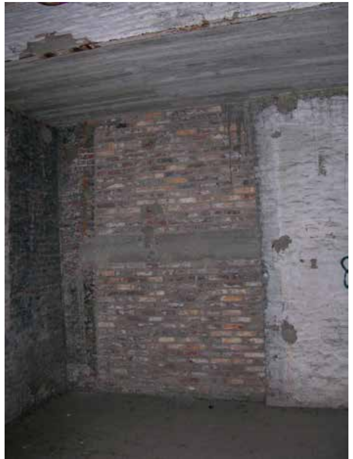
50. De zuidoost-hoek ter plekke van de hoge voormalige opening in de zuidgevel
