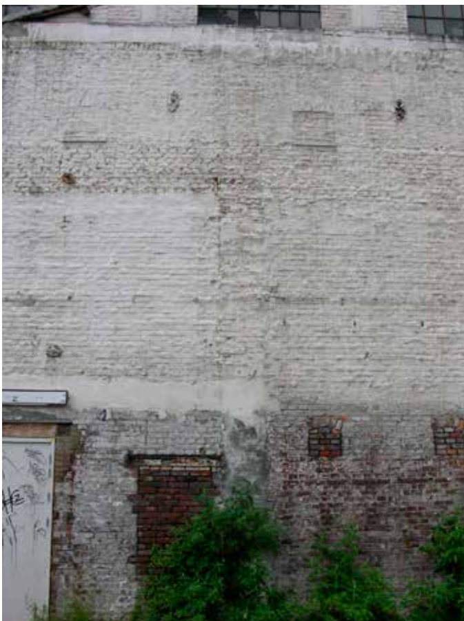
2. Het oorspronkelijke tweelaagsgebouw uit 1875 had op beide niveau's kleine openingen met segmentboogvormige bovenkanten. Tegen de muur zijn aftekeningen te zien van aangehechte muren van verdwenen gebouwen
