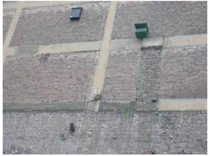
12. De noordgevel heeft ook weer aanzetten van verdwenen muurwerk
