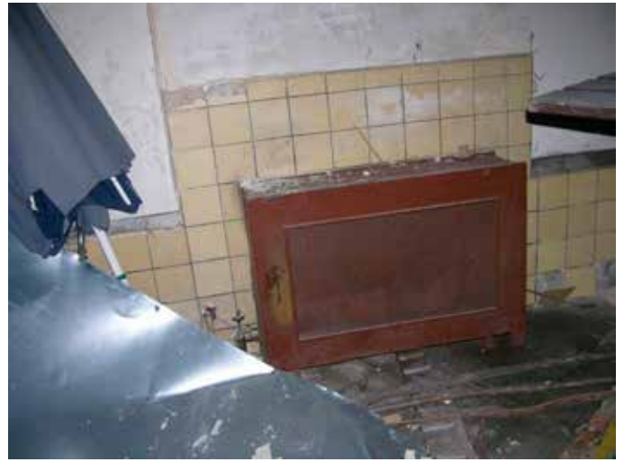
43. De ruimte daarachter is betegeld, en zelfs voorzien van een schouw. Kennelijk was dit een kantoorruimte
