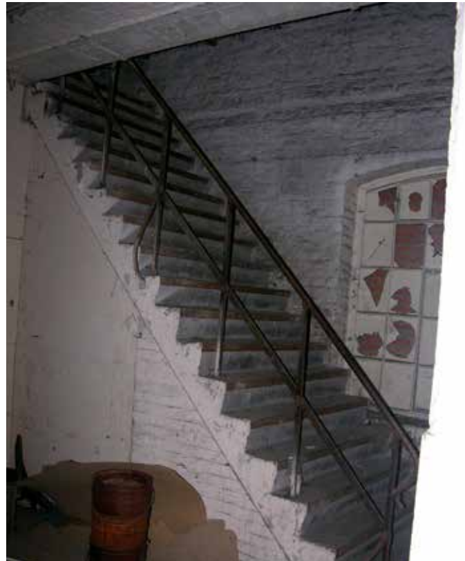
35. De secundair geplaatste trap tegen de zuidgevel, als vervanging van de oorspronkelijke trap in het trappenhuis annex liftkoker. De trap heeft, omdat die een bepaalde hoogte moet overbruggen, smallere treden dan hoger op in het gebouw, waar de afstand tussen vloer en plafond lager is
