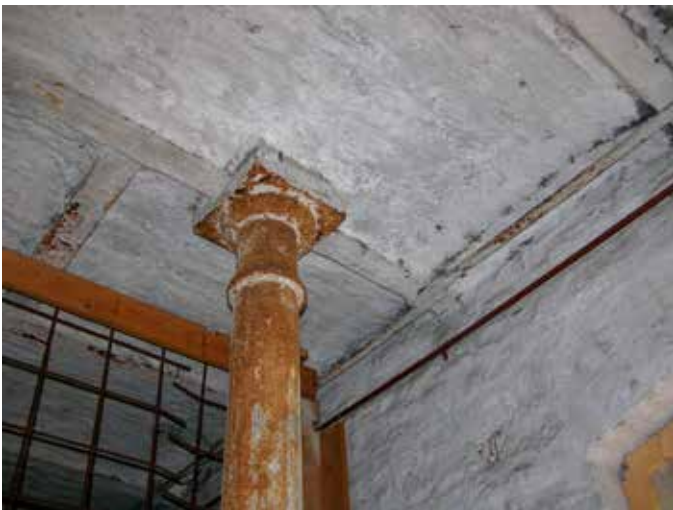
58. Daarnaast staat een gietijzeren kolom waarvan niet duidelijk is of die deel uitmaakte van een groter geheel, of dat die daar secundair een functie heeft gekregen
