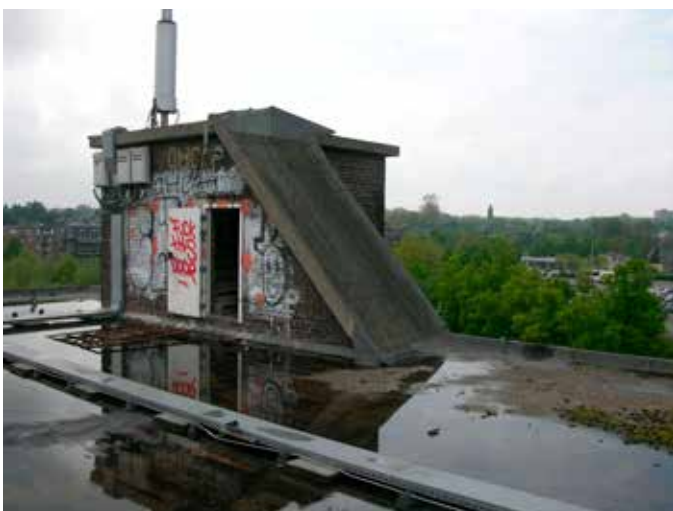
28. De liftkoker. Onder het schuine deel loopt de trap vanaf de bovenste bouwlaag
