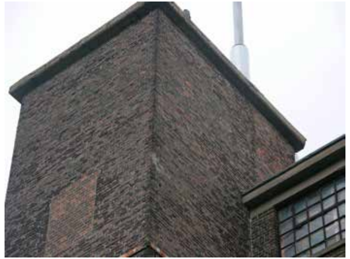
21. Na het plaatsen van de motor voor de lift is de koker aan de dakkant dichtgemaakt, waarbij een venster is vervallen
