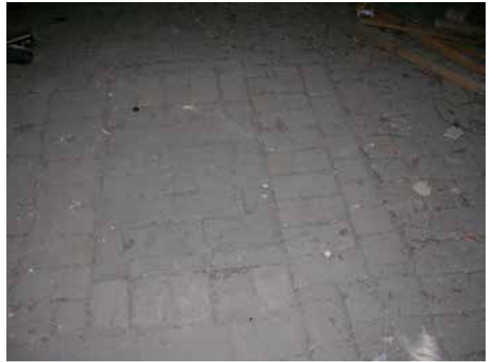
53. In het plaveisel zijn voormalige openingen herkenbaar
