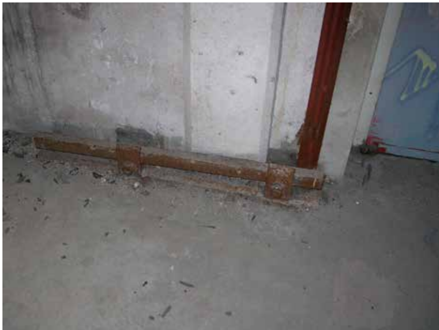
100. De bevestiging van de ijzeren banden om de liftkoker te zekeren komen op elke verdieping terug
