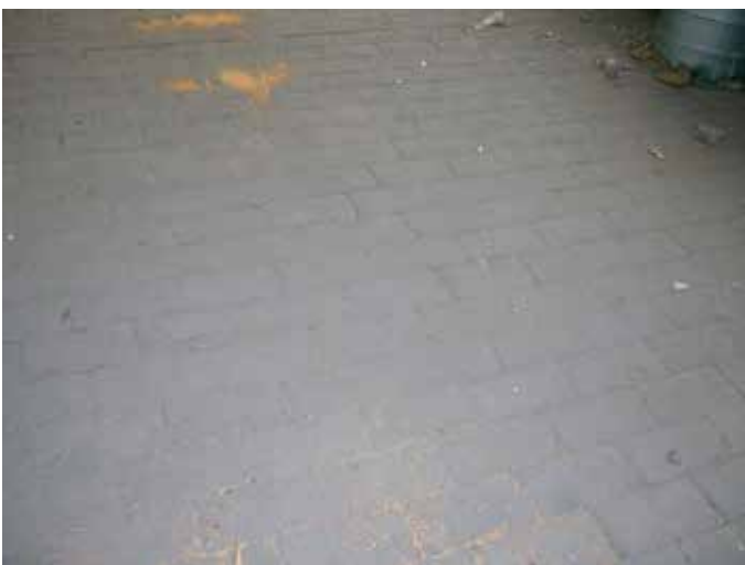
70. De vloer bestaat uit bakstenen op hun platte kant
