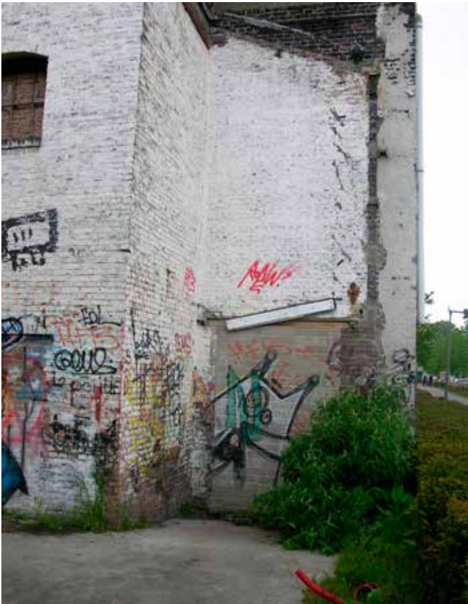
18. Achter het voormalige trappenhuis, nu liftkoker, zit aan de zuidwest-hoek een deur
