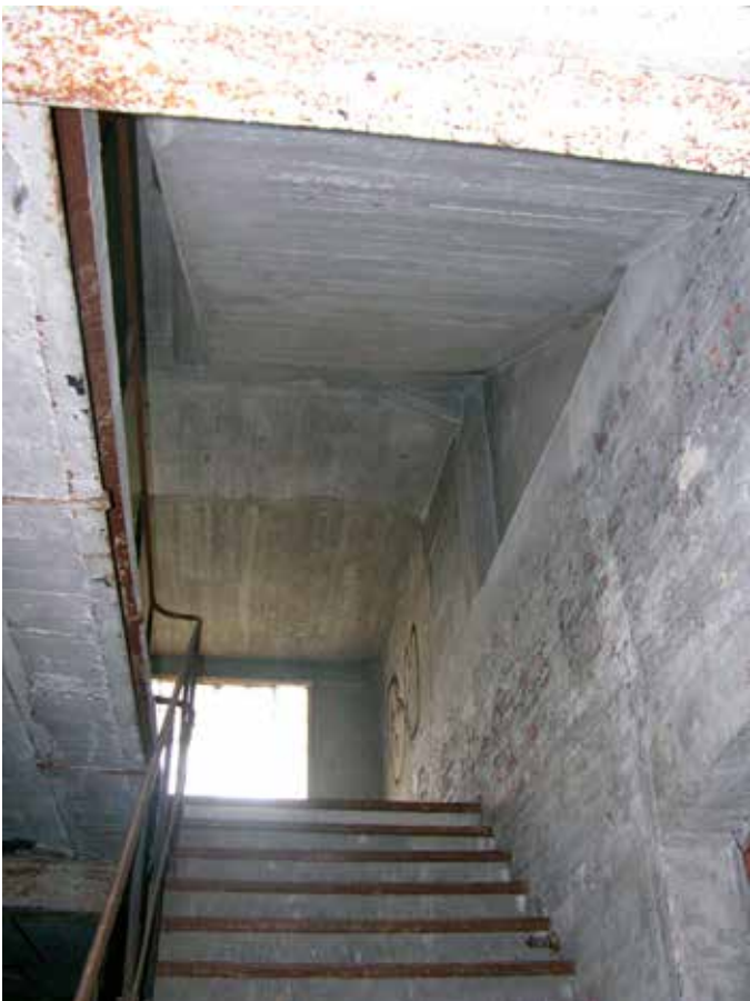
66. Doorkijk naar de derde bouwlaag, de eerste van de ophoging
