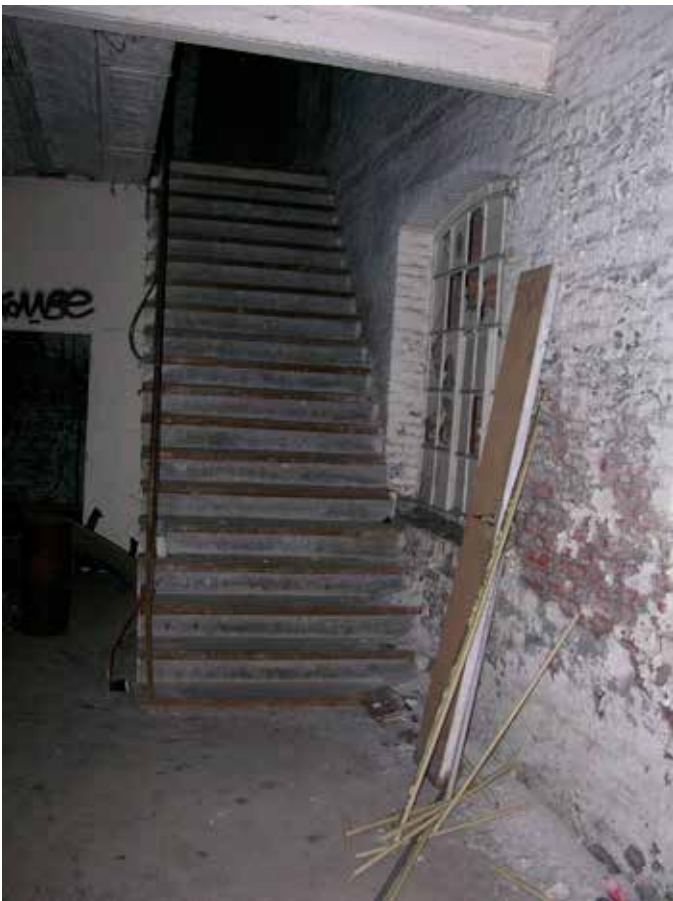
36. De betonnen treden hebben ijzeren stootregels. De leuning bestaat uit staafijzer
