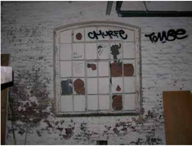
34. Weggemetseld venster in de zuidgevel
