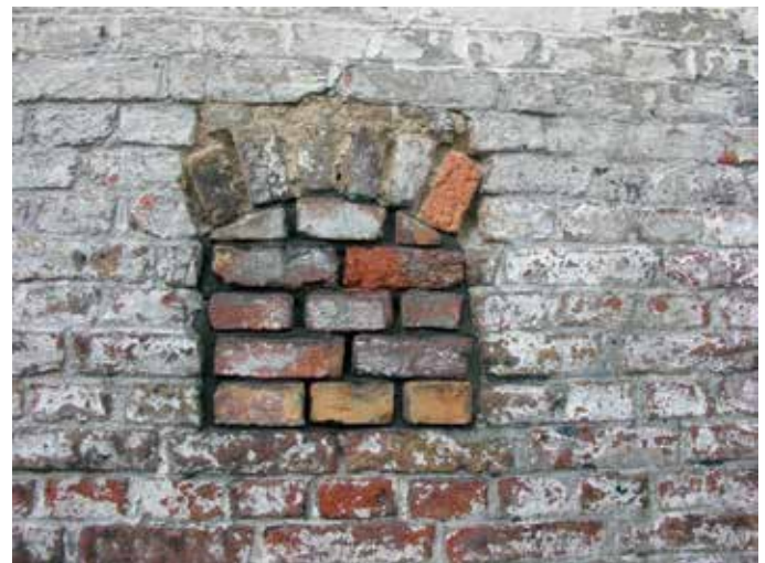
6. Ook de inpassing van de boogjes zelf laat zien dat ze secundair zijn
