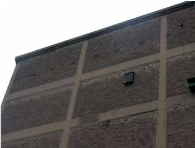
13. Een rij gaten in het bovenste segment verwijst naar een verdwenen dak of vloer
