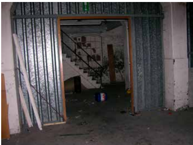
45. Richting zuidgevel is de ruimte afgeschoten met damwandprofielen
