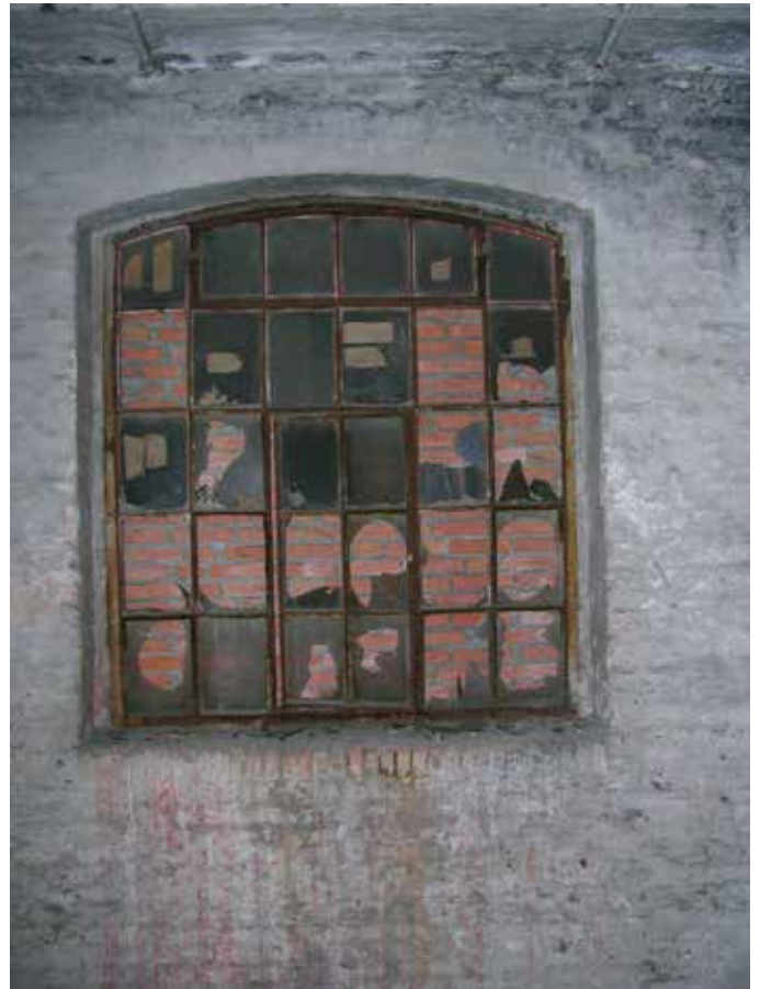
65. Venster in de zuidgevel
