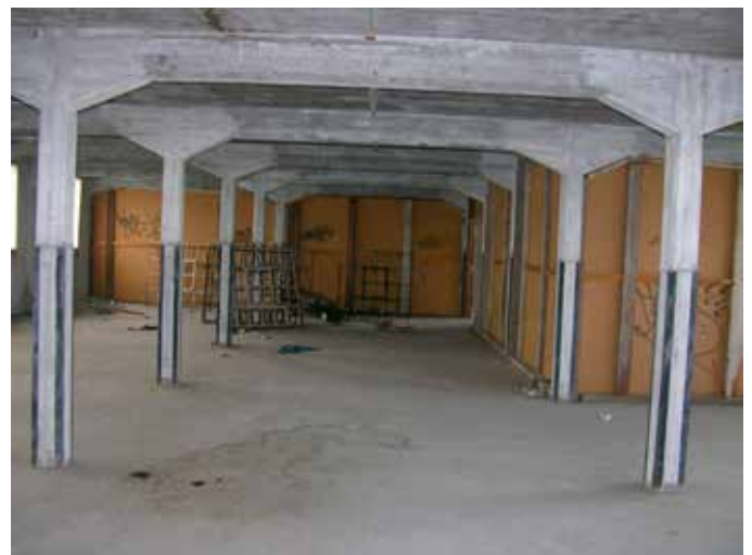
91. De ruimte naar het zuiden gezien. Naast de trap staat een scheidingswand
