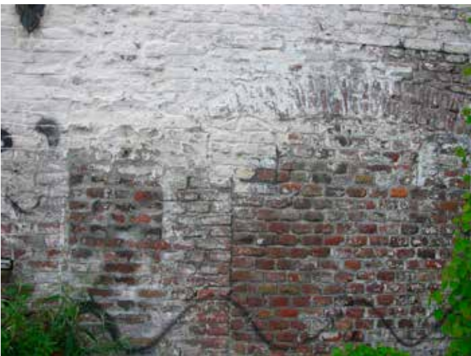
5. Dat de kleine openingen secundair zijn is te zien aan de plaatsing van het exemplaar op de foto, dat immers binnen een eveneens dichtgezette grotere opening is aangebracht
