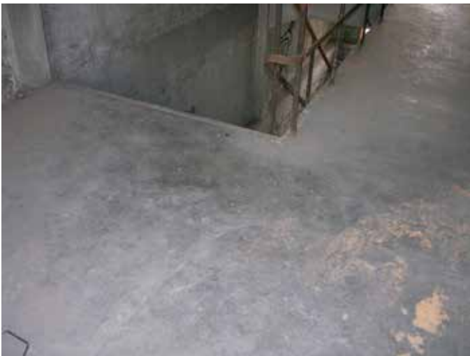
78. Hier bestaat de vloer uit beton met een afwerklaag van cement
