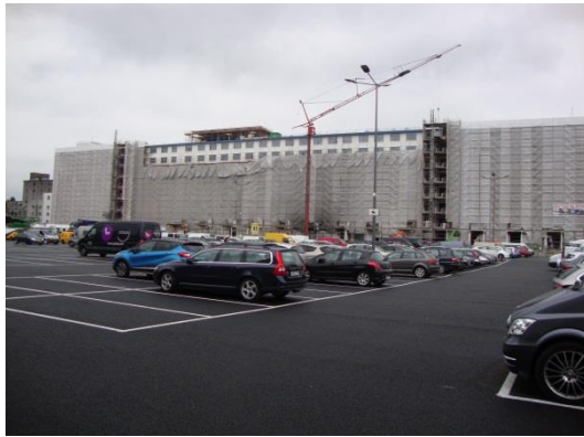
Parkeerplaats met verbouwing Eiffelgebouw
