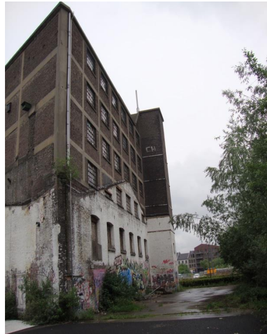
Brikkengebouw, zijde Frontensingel (westzijde)
