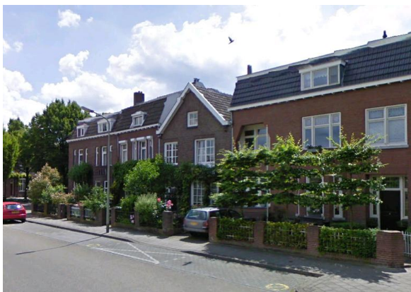
Woonbebouwing aan het Sterreplein
