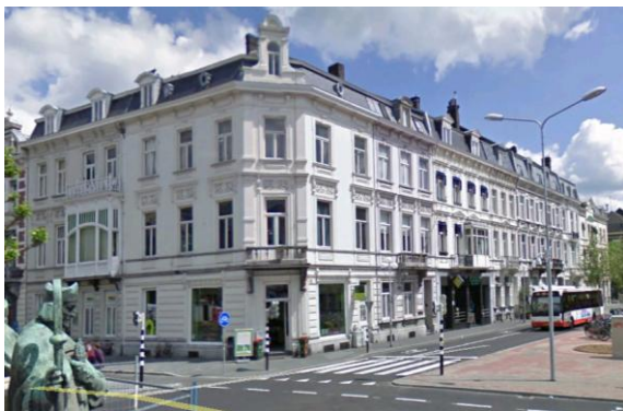
Stationsstraat: drie bouwlagen, hoekafsnijdingen
