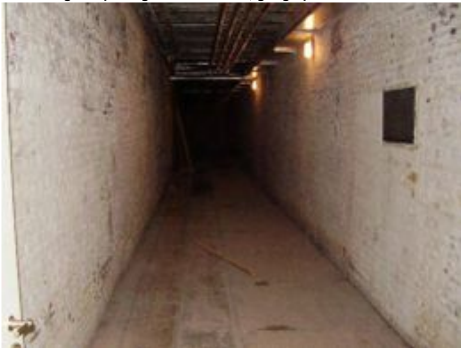
afbeelding 9. inpandig Timmerfabriek, gang op kelderniveau
