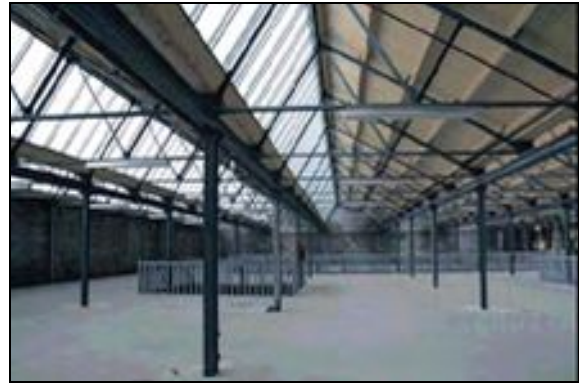
Afbeelding 2.6.: Bovenverdieping Timmerfabriek na renovatie
