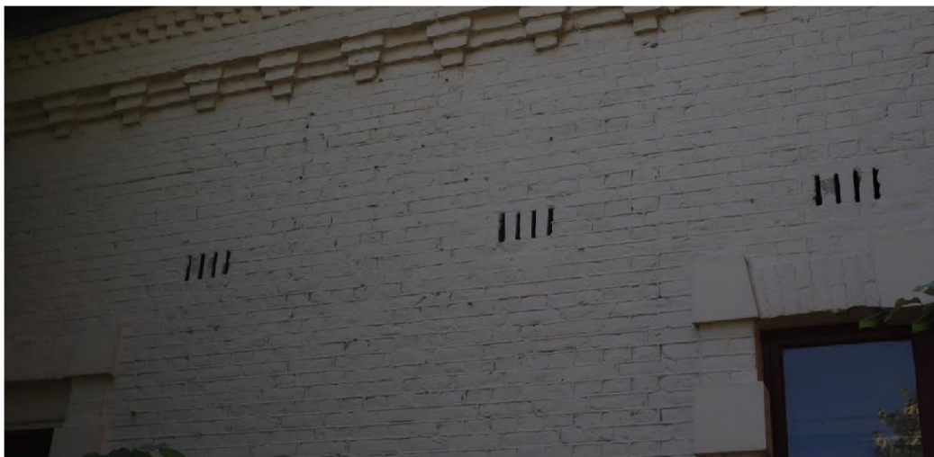
Foto 3: verticale ventilatieopeningen in het Koetshuis
