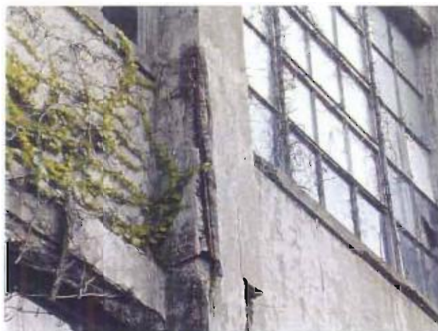
Figuur 6 Detail van de gasfabriek
