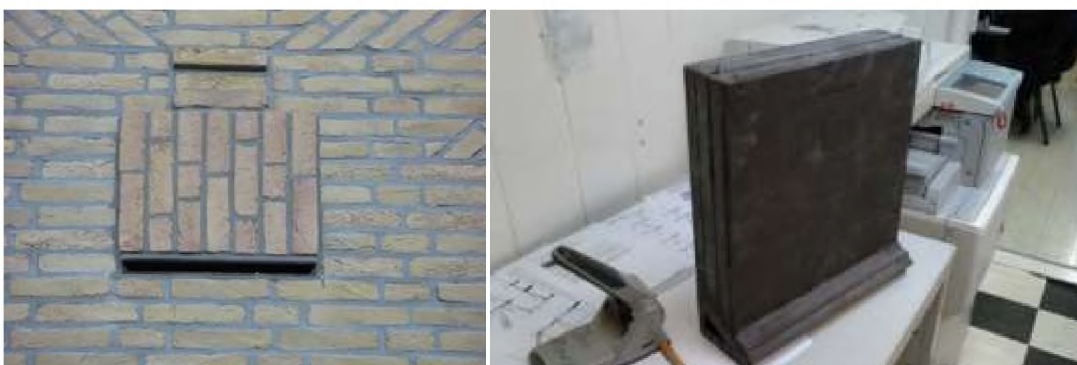
Afbeelding 3: Voorbeeld mitigatie vleermuizen, links; vleermuiskast vivara, rechts; inmetse kast vivara, onder inbouw type Tichelaar.
