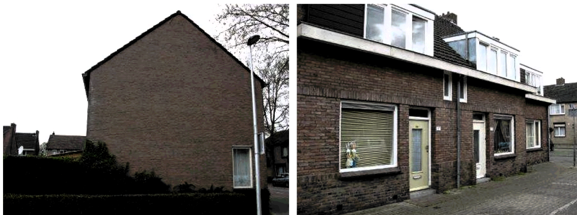
Figuur 2: Complex TECH-126-01 (links) en TECH-102-01 (rechts).
