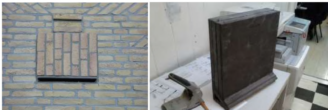
Afbeelding 3: Voorbeeld mitigatie vleermuizen, links; vleermuiskast vivara, rechts; inmetselfkast vivara, onder inbouw type Tichelaar.
