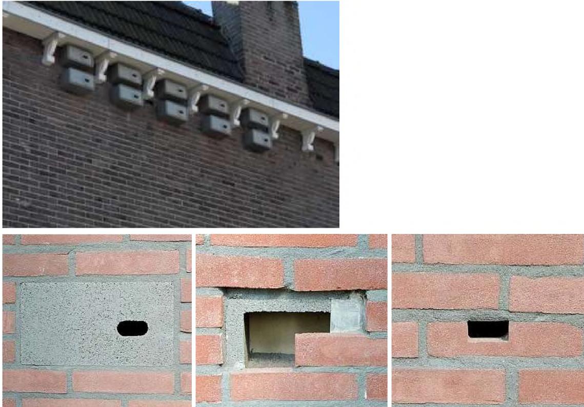
Afbeelding 2: Voorbeeld mitigatie gierzwaluw, boven; nestkast, onder; inmettselkast.
