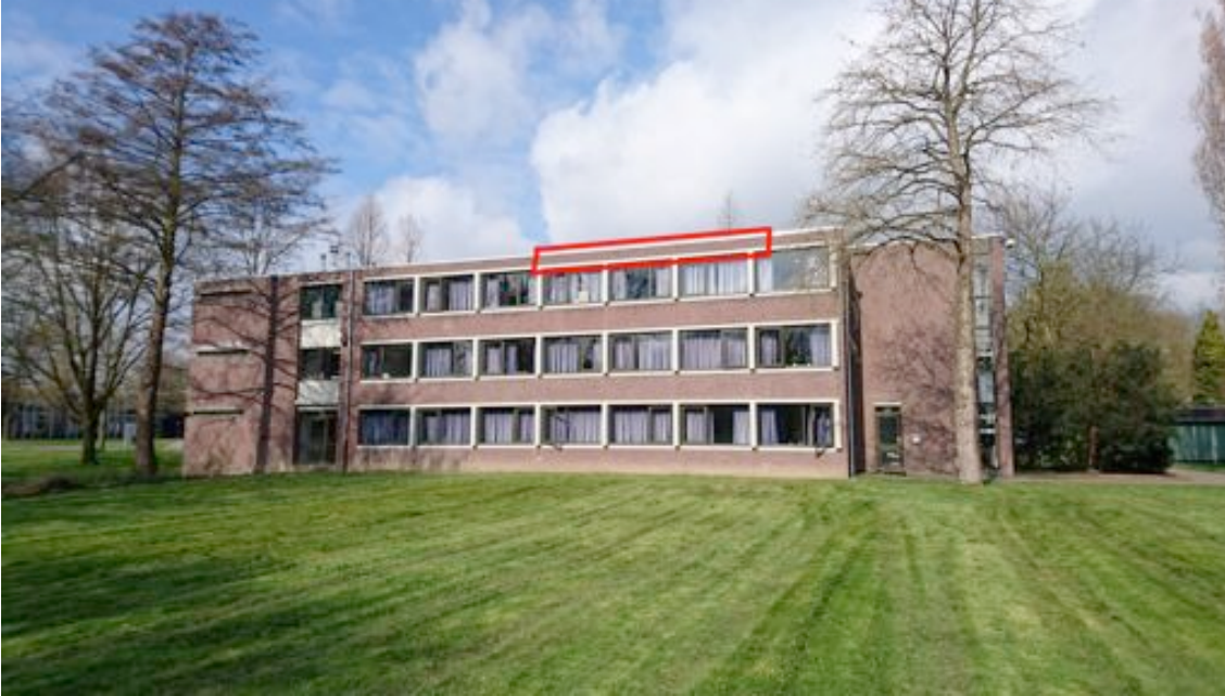
Afbeelding 4: Locatie kraamverblijfplaatsen in gebouw 1, rood gemarkeerd. De kraamverblijfplaatsen bevinden zich in de spouwmuur en zijn toegankelijk via open stootvoegen. Foto: Ecoresult B.V.
