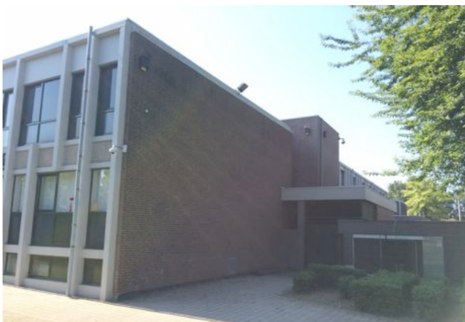
Drie Schwegler 1FF kasten, opgehangen aan westgevel van het onderwijsgebouw ten zuiden van het plangebied.
