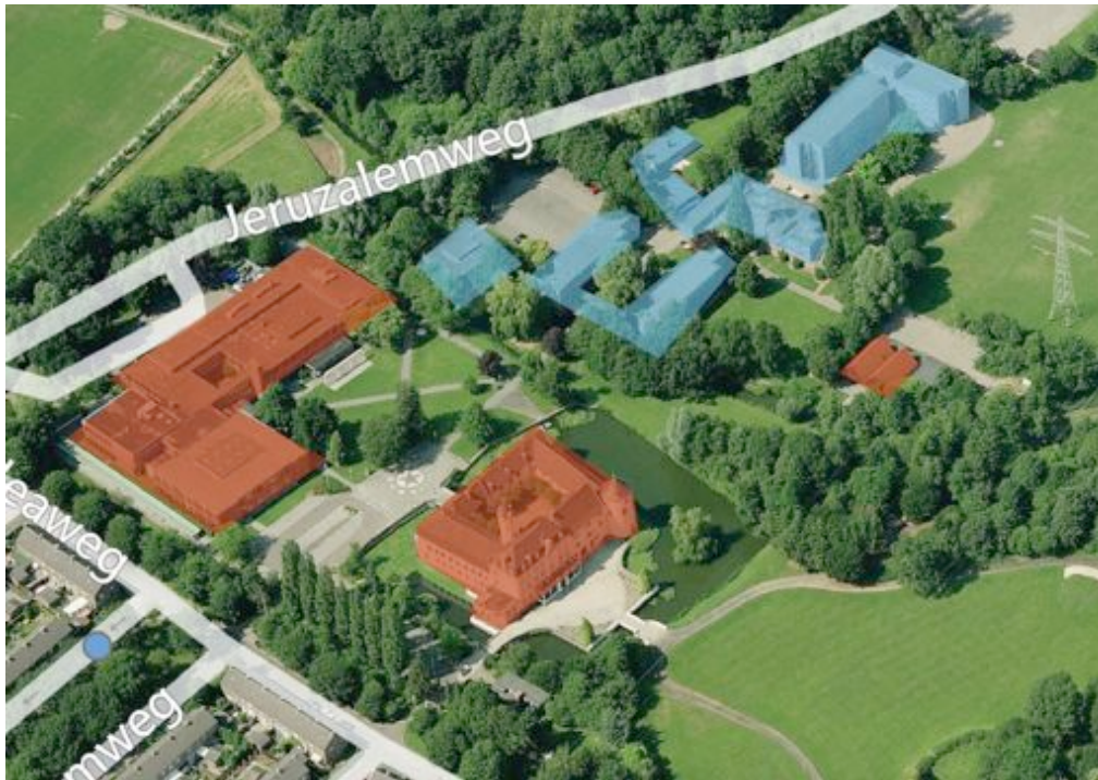
Afbeelding 2: Het plangebied. De te slopen bebouwing is blauw gekleurd. De rood gekleurde bebouwing valt buiten het plangebied en zal niet worden aangetast. Bron: Opdrachtgever.
