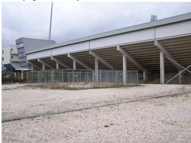
Fotonummer: 3 Omschrijving: Noordelijke deel onderzoekslocatie met hekken
