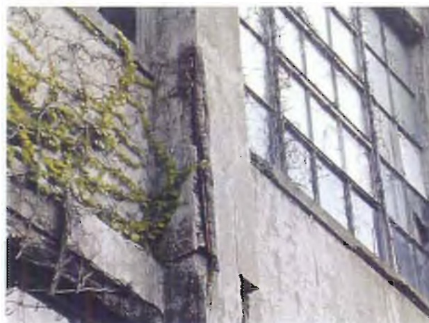
Figuur 6 Detail van de gasfabriek
