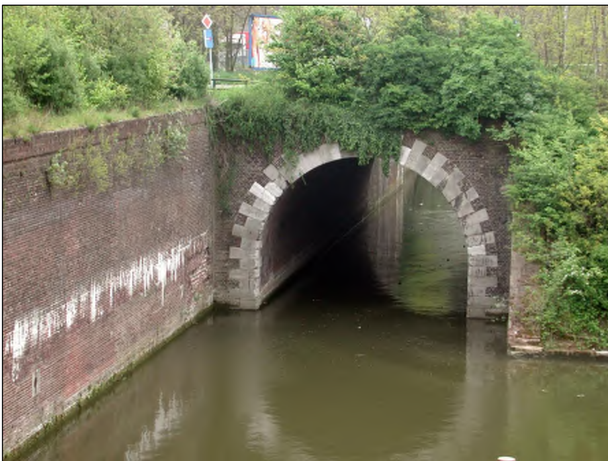
Figuur 8: foto met de nu nog bewaarde gewelfde doorgang uit 1825, die was aangelegd om het Bassin te verbinden met de Zuid-Willemsvaart.
