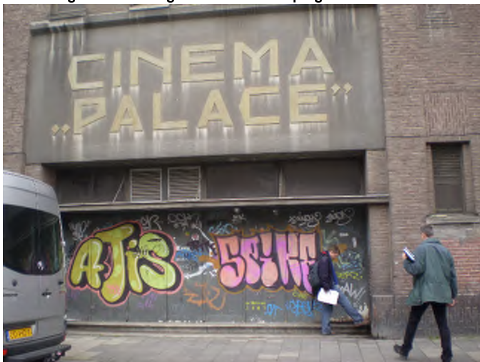
afbeelding 33. Voormalige Palace bioscoop - gevel
