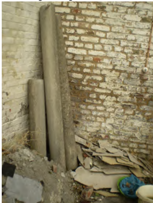
afbeelding 17. Lage Barakken - asbestverdacht materiaal
