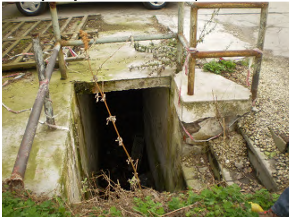
afbeelding 13. Lage Barakken - inrit: aan zuidzijde kelderruimtes aanwezig
