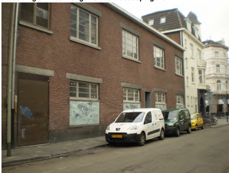
afbeelding 34. Voormalige Palace bioscoop - gevel
