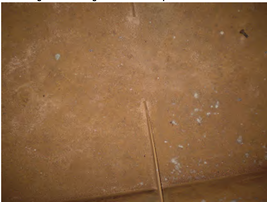
afbeelding 38. Voormalige Palace bioscoop - binnenkant tank
