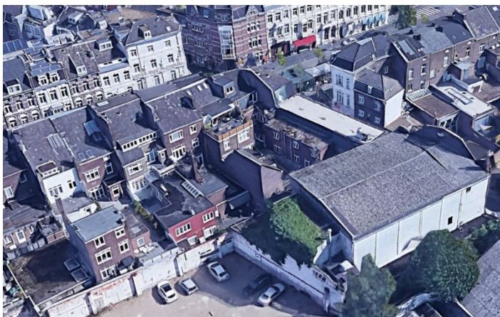
Figuur 9 Hoek Wycker Brugstraat, Lage Barakken: achtergevels
