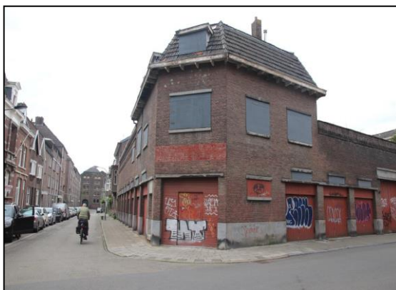
Zicht op hoek Lage Barakken/Bourgognestraat
