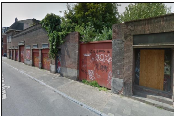
Garagepoorten aan de Lage Barakken
