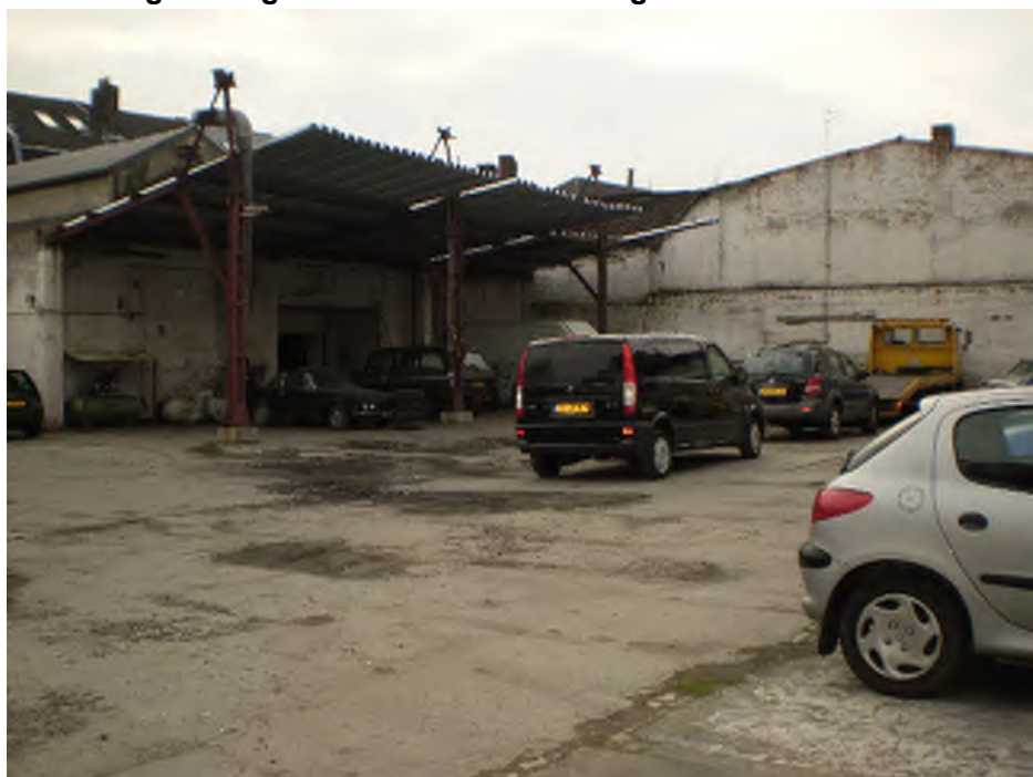
afbeelding 14. Lage Barakken - autostalling
