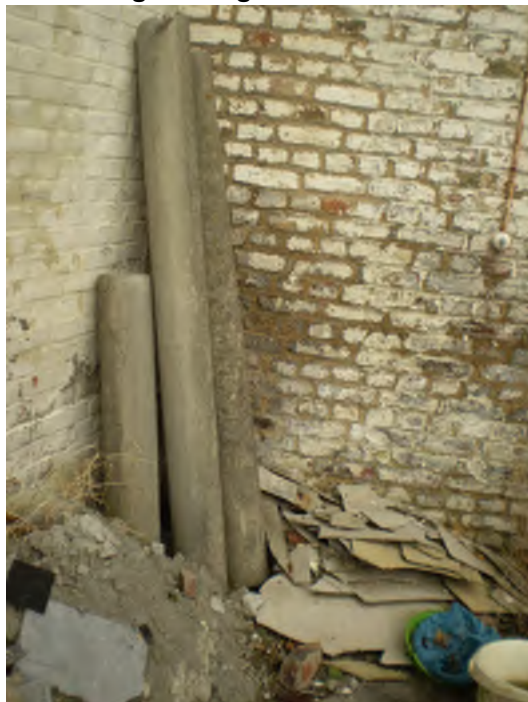
afbeelding 17. Lage Barakken - asbestverdacht materiaal
