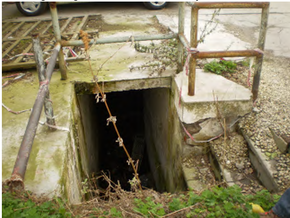
afbeelding 13. Lage Barakken - inrit: aan zuidzijde kelderruimtes aanwezig
