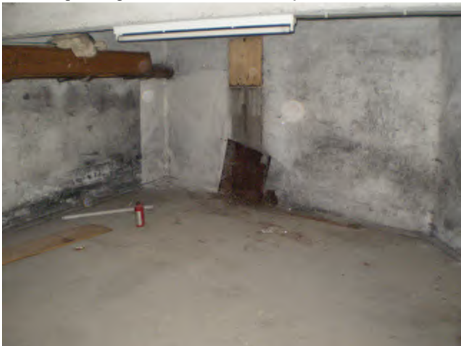
afbeelding 32. Lage Barakken - kelder in dit pand
