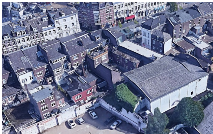
Figuur 9 Hoek Wycker Brugstraat, Lage Barakken: achtergevels
