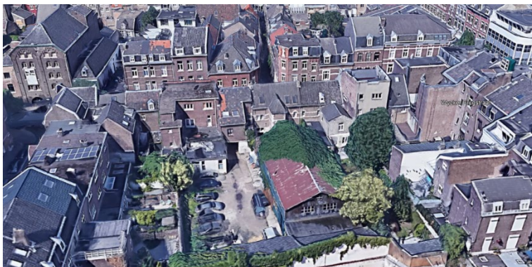
Figuur 7 Achtergevels Wycker Grachtstraat
